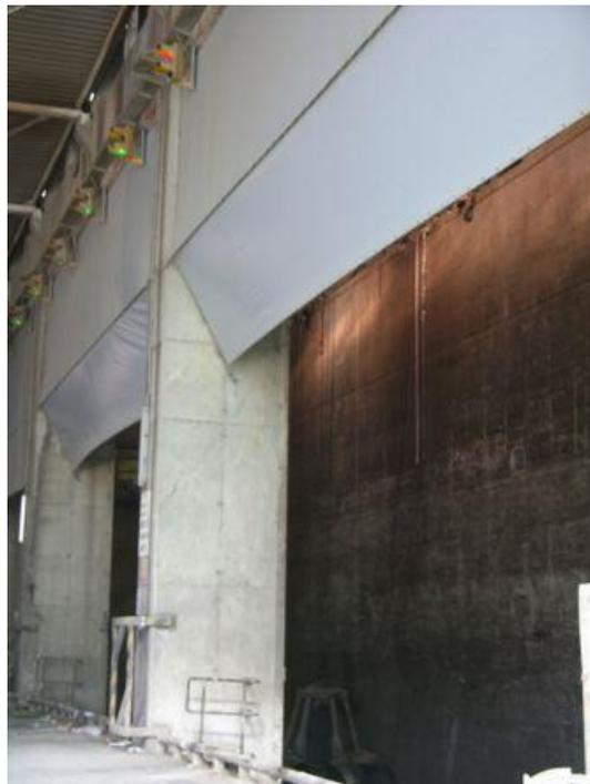
Figura 9: Lonas en puertas de descarga en L12
