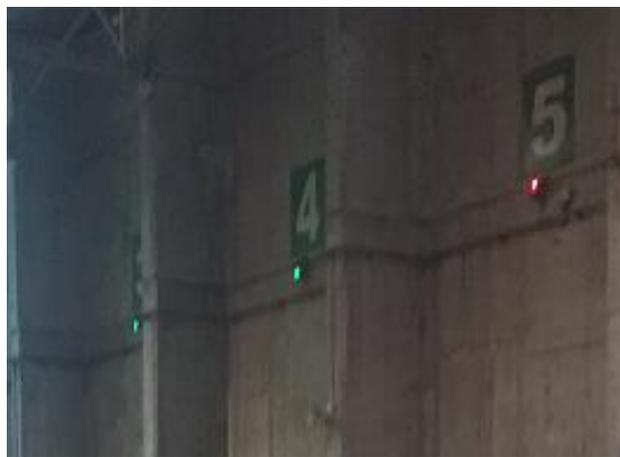
Figuras 3: Semáforos en zona de descarga en L12 y L34 respectivamente
