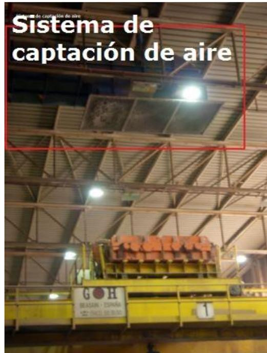
Figura 8: Sistema de captación de aire
