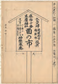
幅60.6cm、縦106cmの大立て札を神社の前、一之橋の角、六本木角の3箇所に
