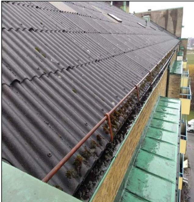
Sadeltak av korrugerad eternit
