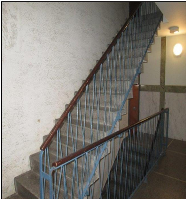
Trapphus med trähandledare
