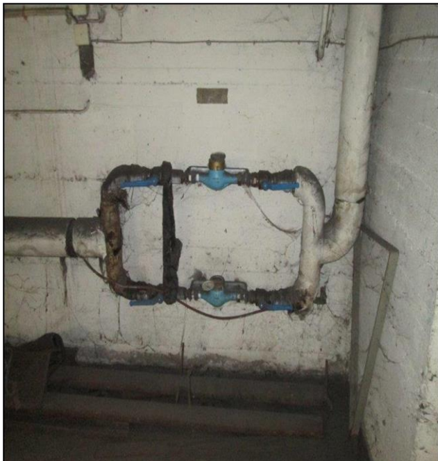
Inkommande vattenledning
