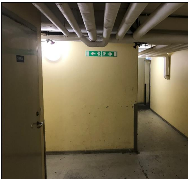
Källare med utrymningsskyltar
