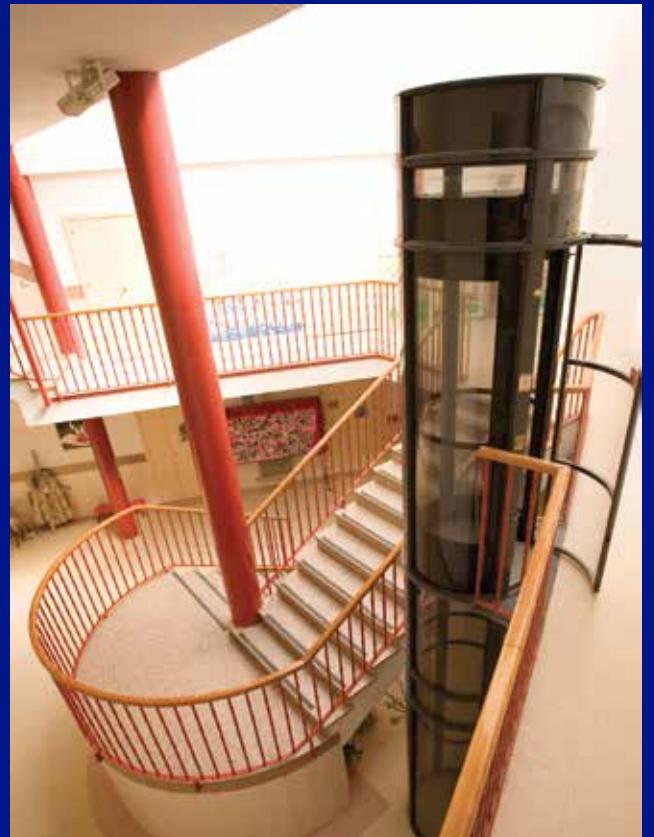
Instalación en hueco escalera
