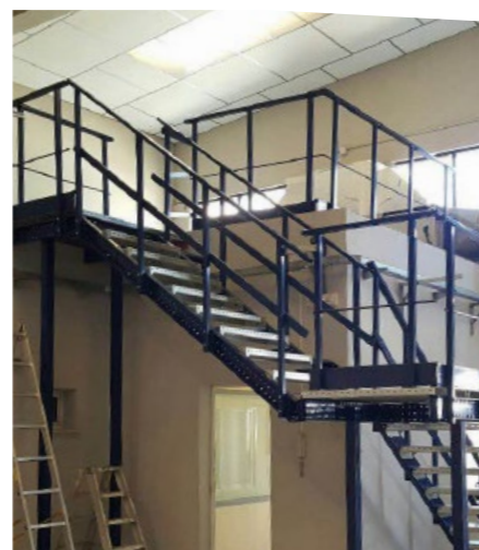
ESCALERA CON RELLANO
