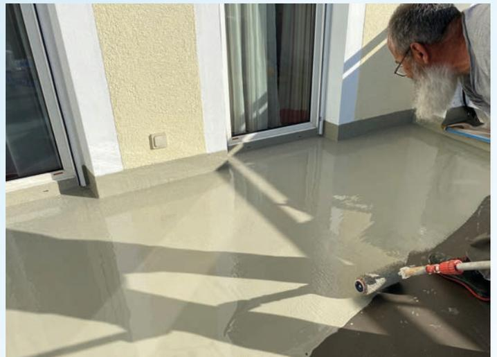
**Eine Balkonsanierung mit Flüssigkunststoff lässt sich an nur einem Tag realisieren. Er legt sich dabei wie eine zweite Haut auch über neuralgische Stellen wie die Übergänge von Boden zur Wand und dichtet so langfristig und sicher ab.**
