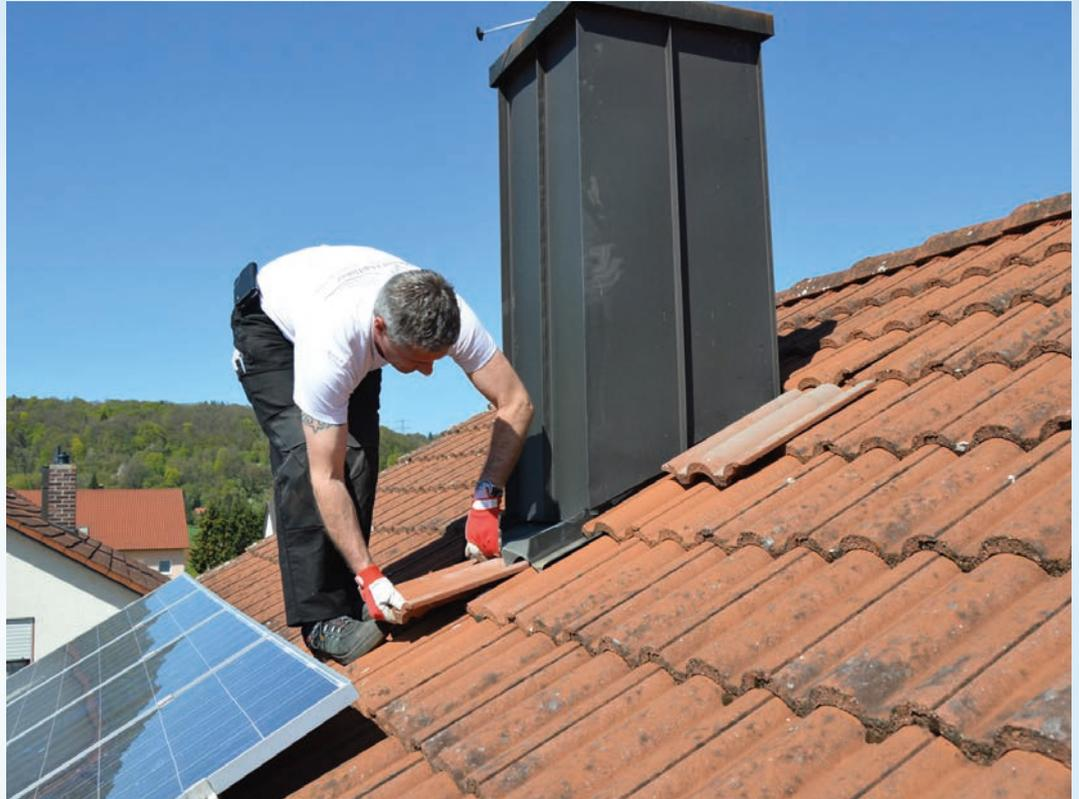
**Anschlüsse an Dachdurchdringungen werden beim DachCheck begutachtet.**
