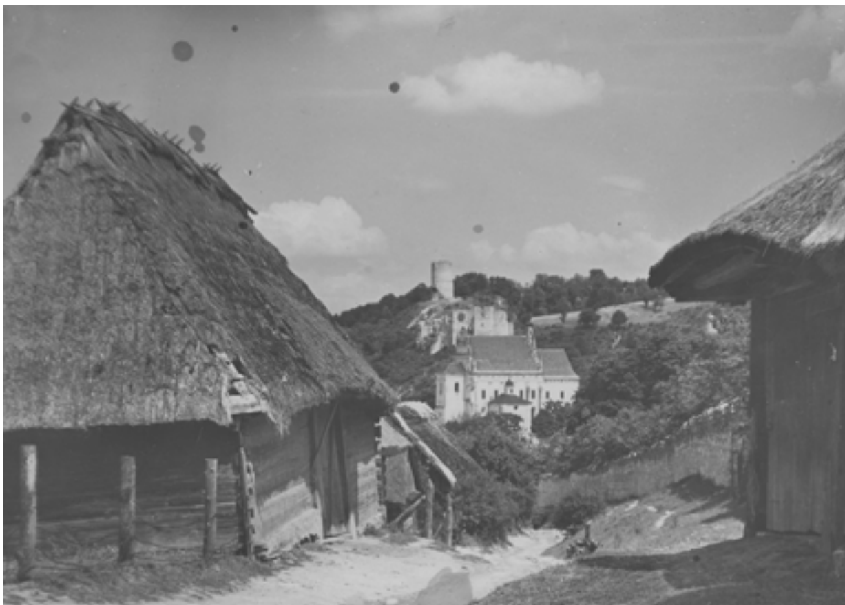
Widok na Kazimierz Dolny nad Wisłą w kierunku północnym. W tle widoczny kościół farny oraz ruiny zamku i baszty, okres międzywojenny, źródło: NAC online
