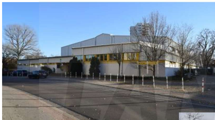
Sporthalle am Kanal
