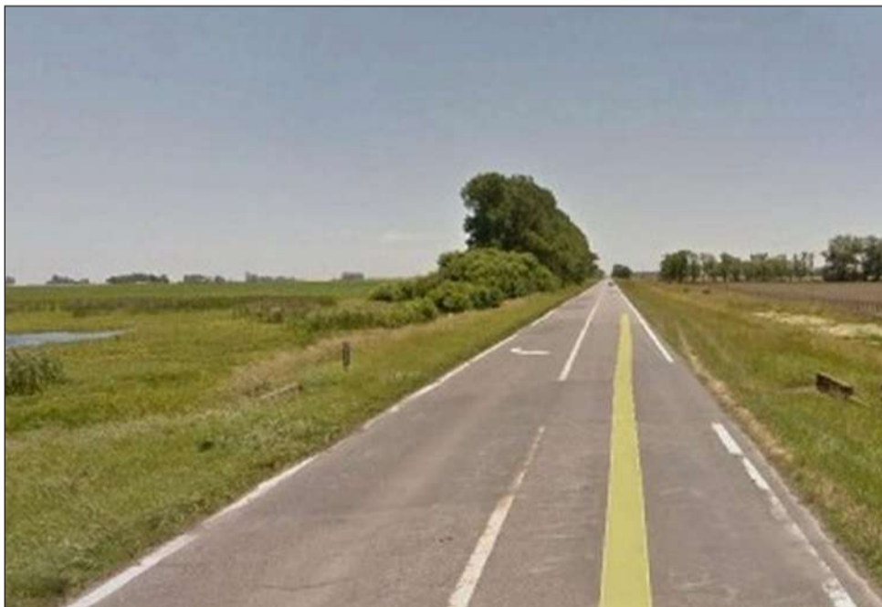
>La obra tendrá un presupuesto de $2.102.633.339,78.
