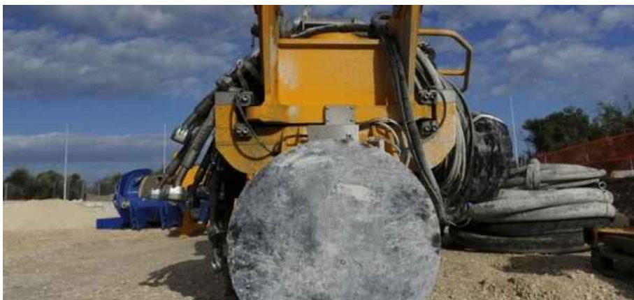
I lavori di costruzione del gasdotto TAP (Lapresse)
