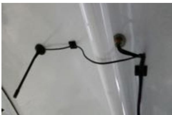
Bild 14: Montage WiFi-Antenne Dach-innenseite
