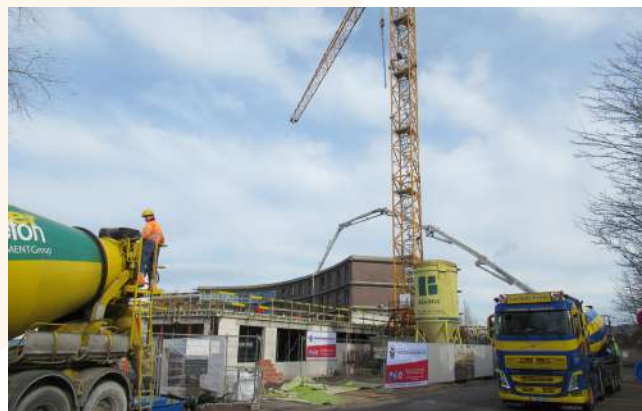
Aanrijden van de vrachtwagens om beton te gieten
