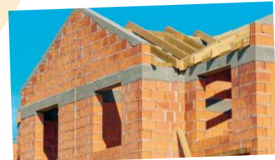
CASA DE ALVENARIA: FEITA DE CIMENTO E BLOCOS.
