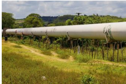
► Tubulação de adutora, em Santo Amaro (BA), em 2016.
