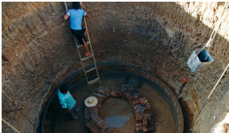
Homens trabalhando na abertura de poço de água em Serra Talhada, Pernambuco, em 2012.
