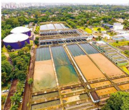
➤ Estação de tratamento de água no município de São Paulo, no estado de São Paulo, 2017.
