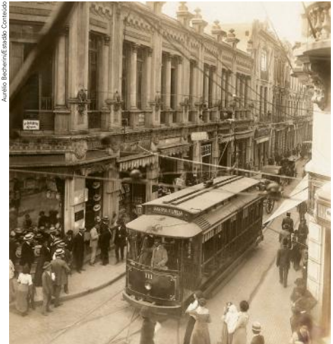
➤ Bonde elétrico no município de São Paulo, no estado de São Paulo, 1906.
