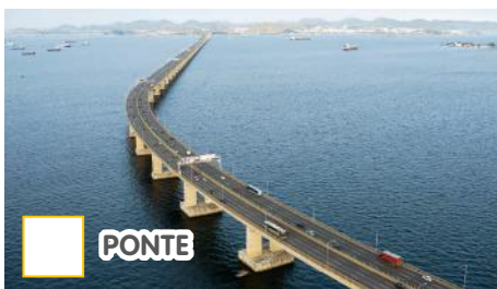
▶ Ponte Rio-Niterói, no município do Rio de Janeiro, estado do Rio de Janeiro, 2016.
