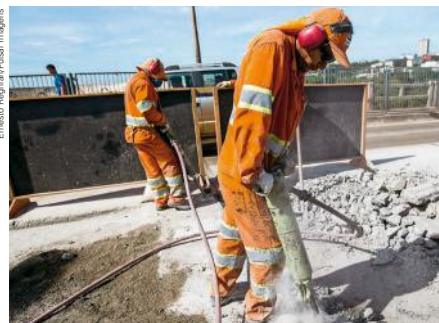
► Homens trabalhando com britadeira em Foz do Iguaçu, no estado do Paraná. Foto de 2015.
