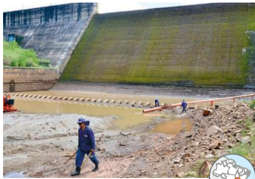
➤ Barragem no rio Descoberto em Ceilândia, no Distrito Federal, 2017.
