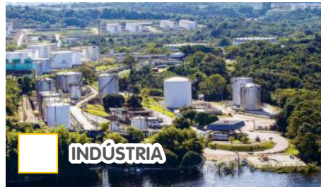
▶ Refinaria em Manaus, no estado do Amazonas, 2015.
