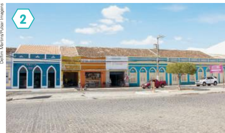
2 Monteiro, no estado da Paraíba, 2016.
