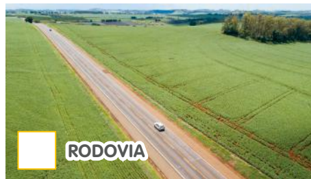
▶ Rodovia BR-369 em Cornélio Procópio, no estado do Paraná, 2016.
