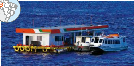
Posto de combustível flutuante no rio Negro, estado do Amazonas, 2017.
