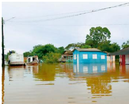
➤ Inundação em Ferreira Gomes, no estado do Amapá, provocada pela Usina Hidrelétrica Cachoeira Caldeirão, 2015.
