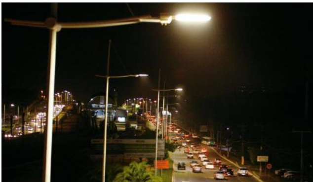
▶ Iluminação pública que utiliza lâmpadas de LED na avenida Paralela, uma das principais vias de Salvador, no estado da Bahia, 2016.
