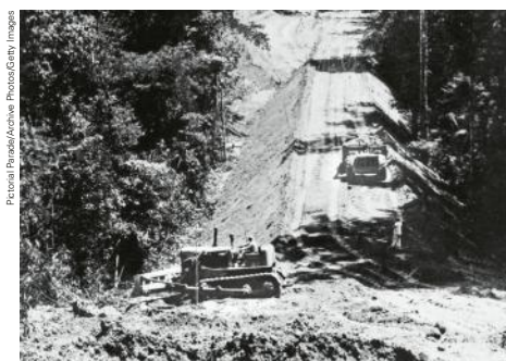
➤ Construção da rodovia Belém-Brasília. Foto de 1970.
