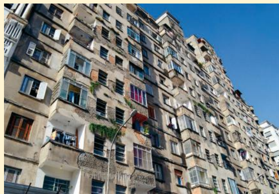
➤ Cortiço instalado em prédio no centro da cidade de São Paulo, em 2016.
