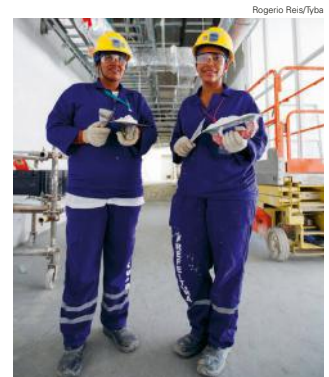
➤ Operárias trabalhando na construção do Parque Olímpico do Rio de Janeiro. Foto de 2015.
