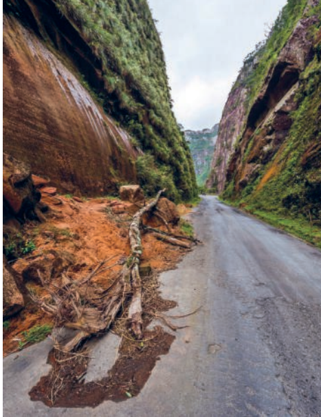
Deslizamento de terra ocorrido na encosta de Mata Atlântica na serra do Rio do Rastro (SC), 2017.
