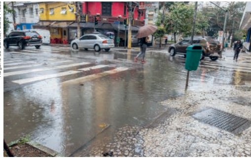
Alagamento causado por bueiro entupido com lixo. São Paulo (SP), em 2017.
