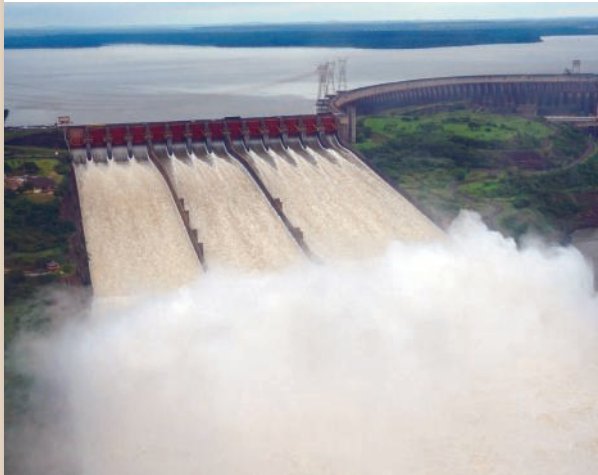
Usina hidrelétrica de Itaipu, em Foz do Iguaçu (PR), 2015.
