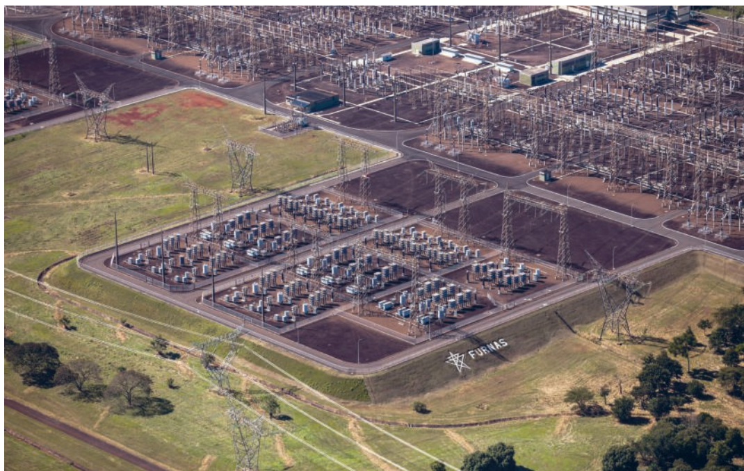
A Subestação de Furnas, em Foz do Iguaçu (PR), 2015, ocupa uma área total de 2 300 000 m 2 e é responsável pela transmissão de grande parte da energia produzida pela Usina de Itaipu para o Brasil.
