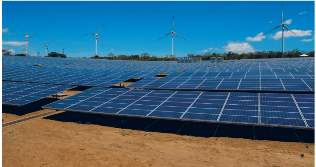
Usina eólica e solar em Tacaratu (PE), 2015.
