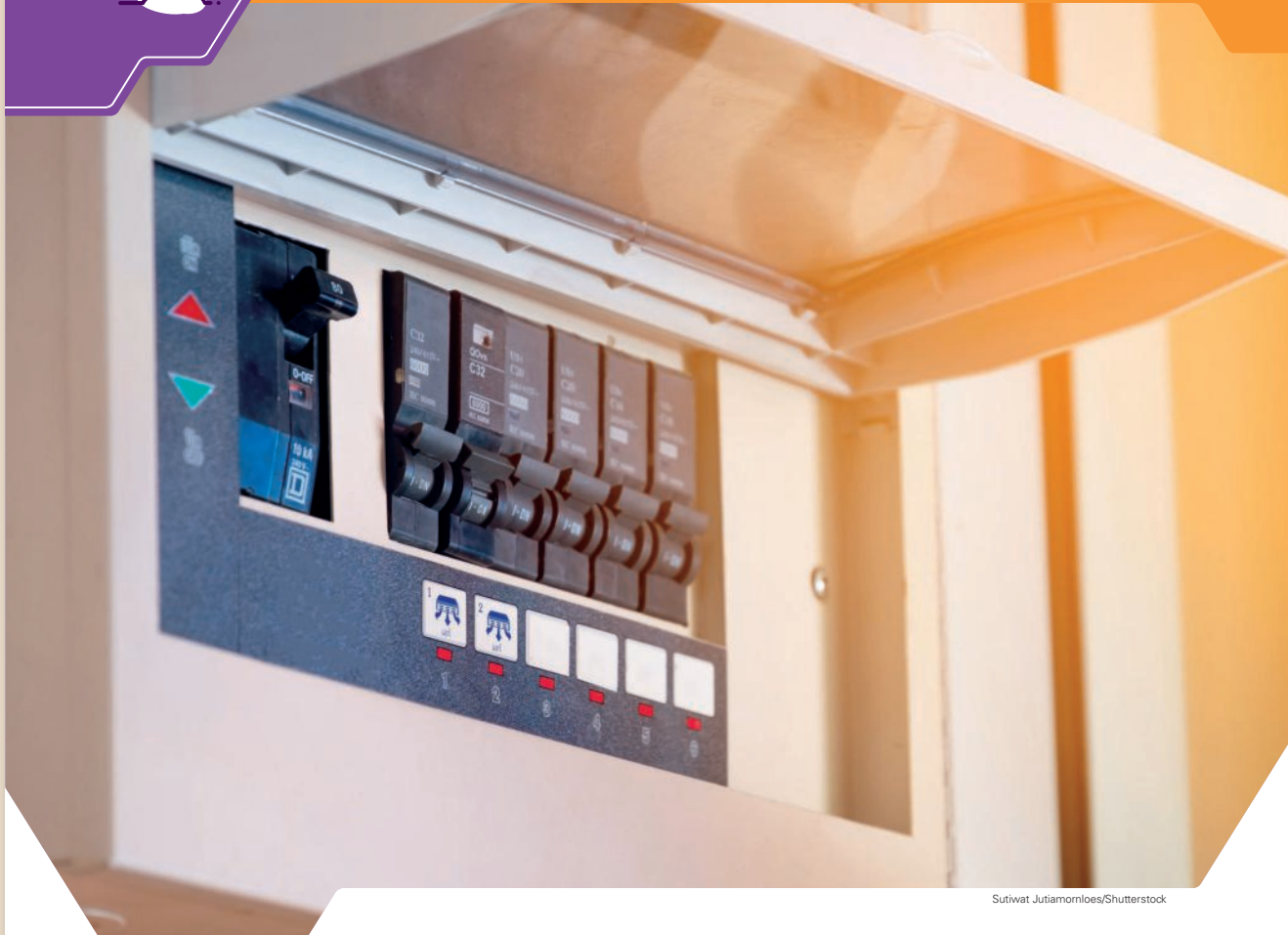
Quadro de energia elétrica de uma residência.
