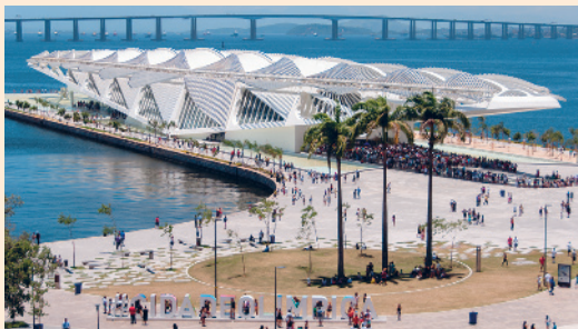
Prédios inteiros podem ser projetados e construídos pensando em garantir o uso racional de recursos (como energia elétrica e água). O Museu do Amanhã (RJ), na foto, recebeu, em 2017, um prêmio internacional na categoria “Construção Verde Mais Inovadora”.
