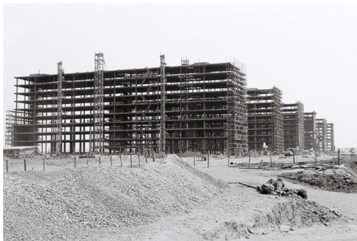
Construção da Esplanada dos Ministérios, em Brasília, em foto de 1959.
