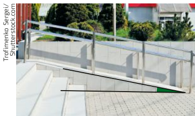
▪ Ângulo de inclinação da rampa.
