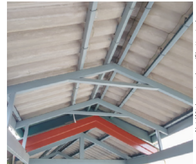
Estrutura de um telhado.
