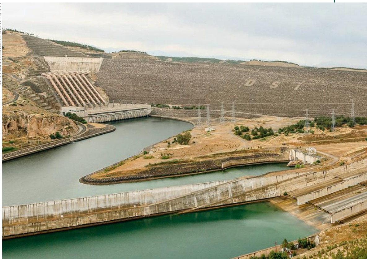
A barragem de Atatürk sobre o rio Eufrates, na região sudeste da Anatólia (Turquia). A barragem faz parte de um plano elaborado pela Turquia para regularizar o fluxo das águas dos rios Tigre e Eufrates, gerar energia e irrigar as planícies da região. Foto de 2014.
