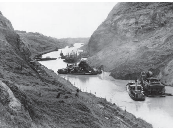
Vista da construção do canal do Panamá em 1913.
