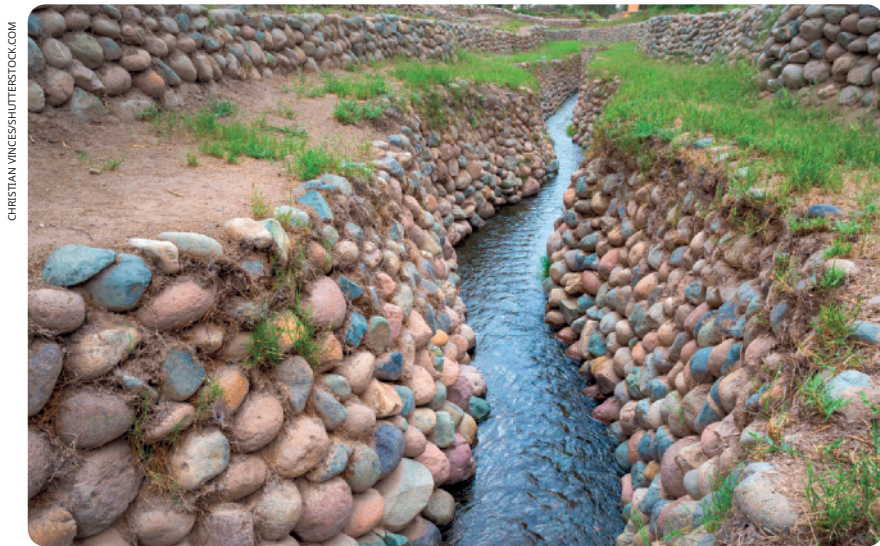
^ Aqueduto construído pelos nazcas cerca de 1500 anos atrás que continua em funcionamento. Nazca, Peru, 2020.
