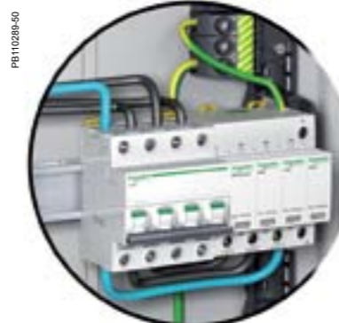
Surge arrester iPRD 3P+N + iC60N 3P+N
