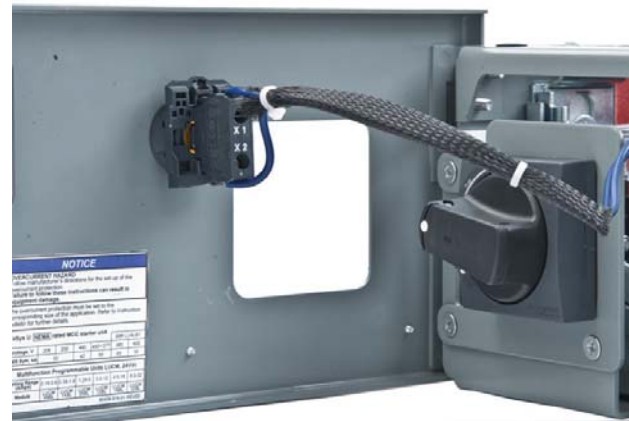
Figura 15: Desconexión del módulo indicador de disparo montado en la puerta
