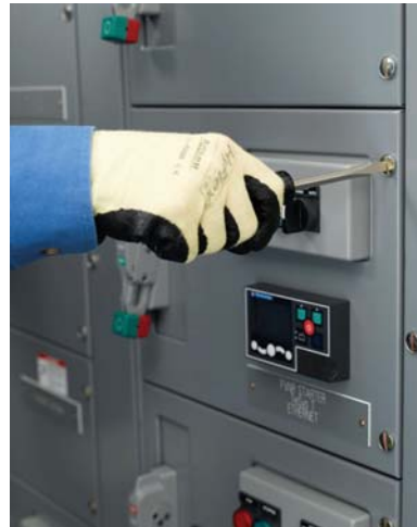
Figura 13: Aflojando los tornillos sujetadores cautivos
