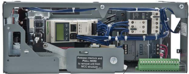
Figure 26 : Retrait de la base puissance
