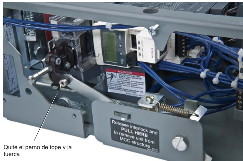
Figura 23: Desmontaje de la leva acodada
