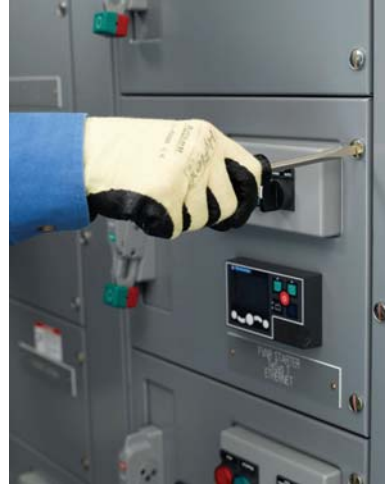
Figure 13 : Desserrage des fixations imperdables
