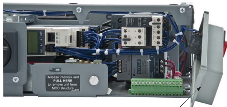
Figura 14: Desmontaje de la placa de estación de control
