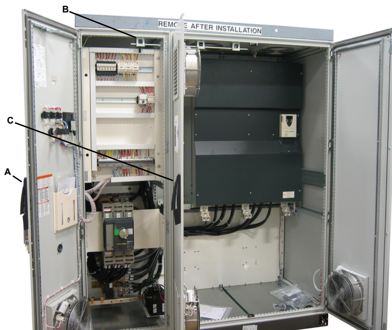
Figura 11: Procedimiento para abrir el bloqueo de la puerta
