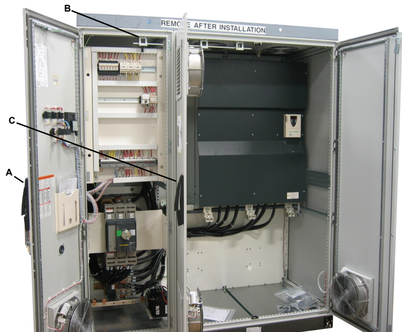
Figure 11 : Procédure d'ouverture de l'interverrouillage de la porte
