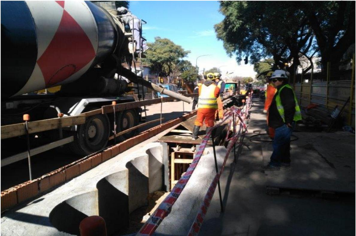
**Foto 23** Obra de pilotaje sector pre túnel a continuación de la Estación Hospitales hacia Estación Sáenz.
