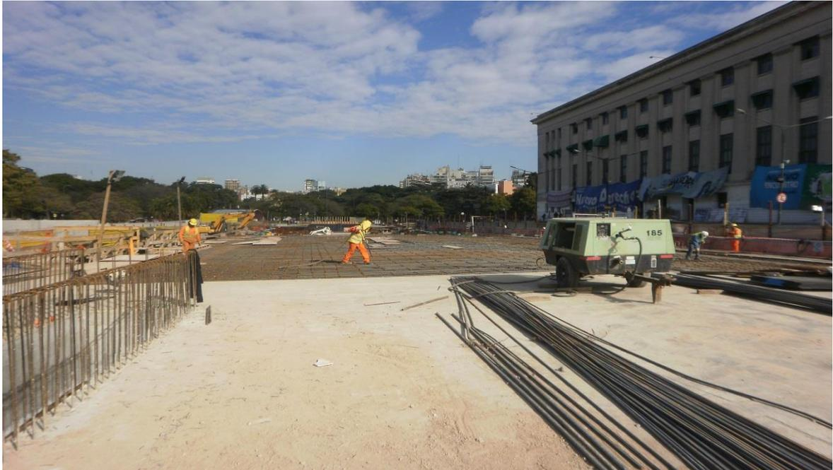
de techo de la estación, ejecución de armadura en 2da. mitad de losa Cut/Cover.
