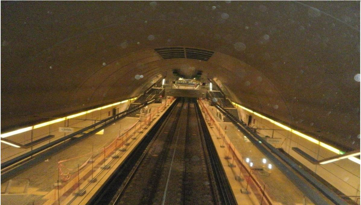
**Foto 3. Santa Fe.** Vista general de la estación y túnel hacia la Estación Las Heras, andenes en obra, se observa la boca de extracción cenital de aire viciado, sistemas de iluminación e inyección de aires.
