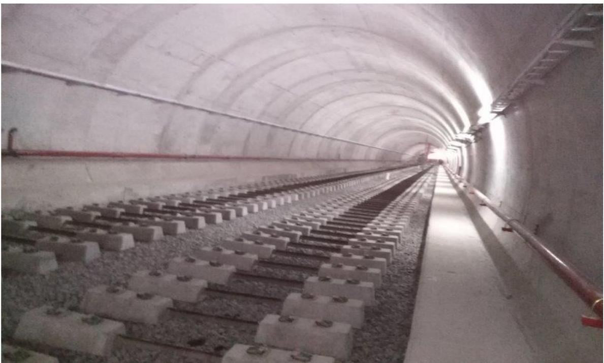
**Foto 20 Cochera Parque Patricios.** Túnel Norte con sistemas de iluminación, cañería antincendios, balasto y durmientes.
