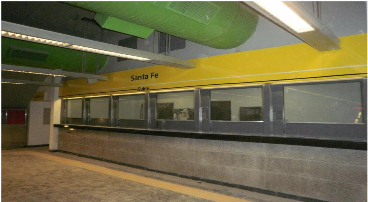
**Foto 7. Santa Fe.** Boleterías blindadas, inyección de aire e iluminación terminados.
