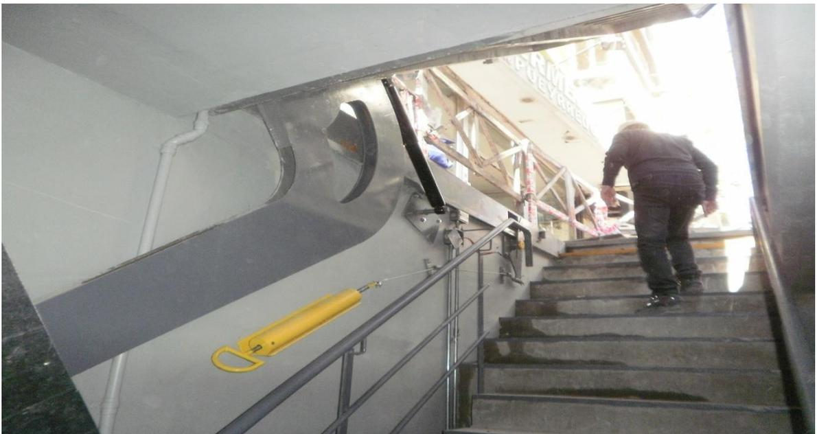
**Foto 10 Santa Fe.** Escalera de emergencia con tapa ciega y salida a la vereda de Av. Pueyrredón.
