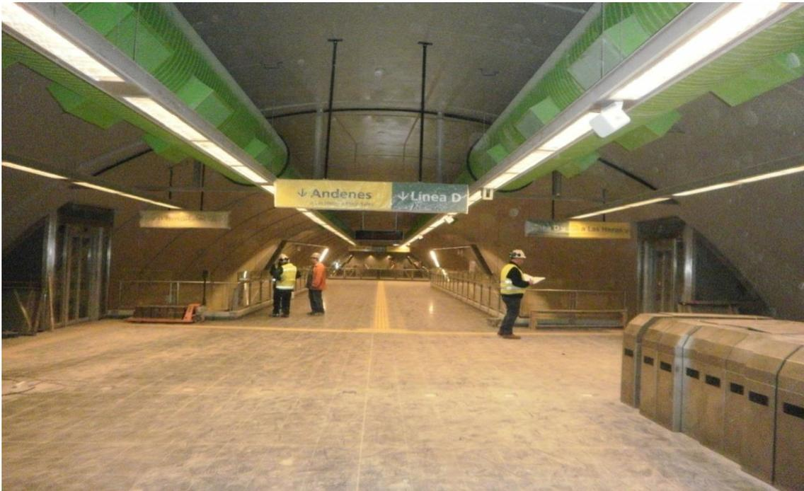
**FOTO 6 Santa Fe. Vestíbulo de la estación en terminación, iluminación, inyección de aire, cartelería ascensores, molinetes a colocar.**
