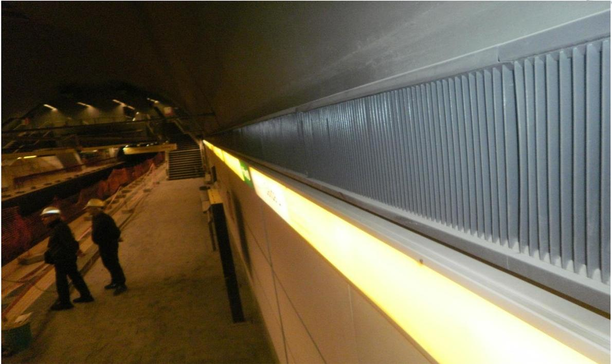
**Foto 5. Santa Fe. Anden en obra, rejas de inyección de aire, iluminación y cartelería.**
