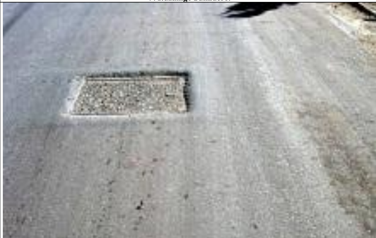
10. José C. Paz Tapa sin colocar. Obra hidráulica sin terminar.
