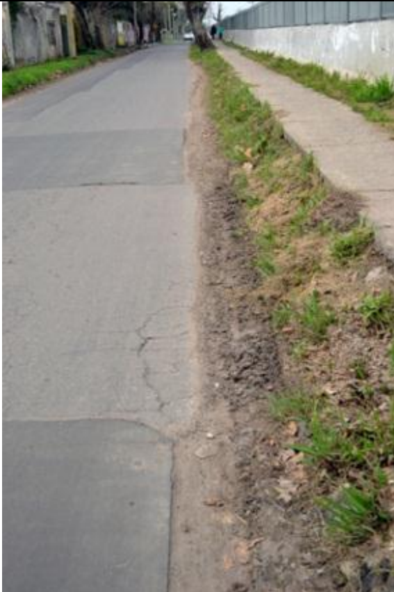
4. Almirante Brown Pavimento agrietado.
