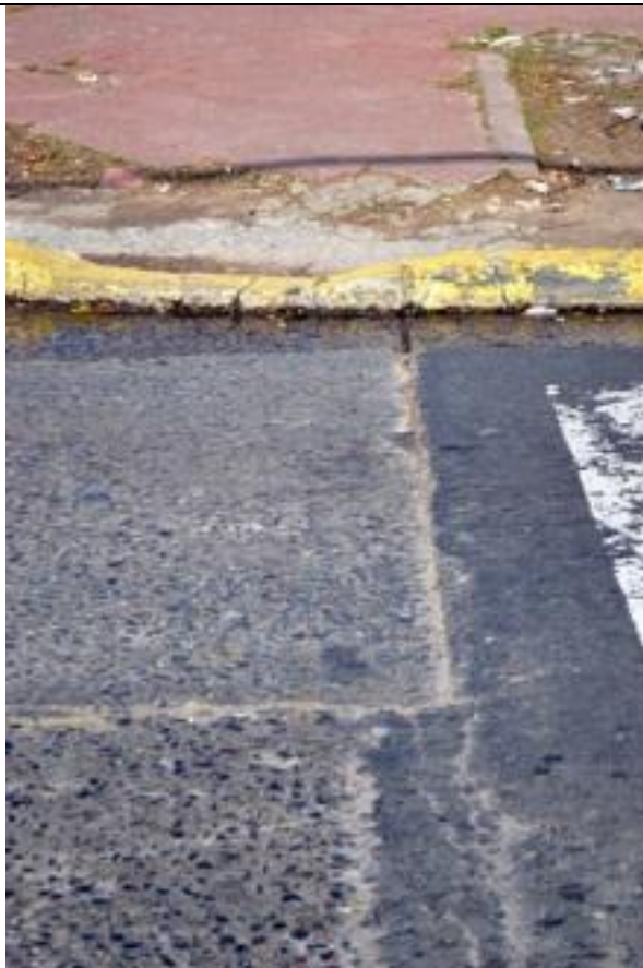
17. Lomas de Zamora Pavimento deteriorado con reparaciones.
