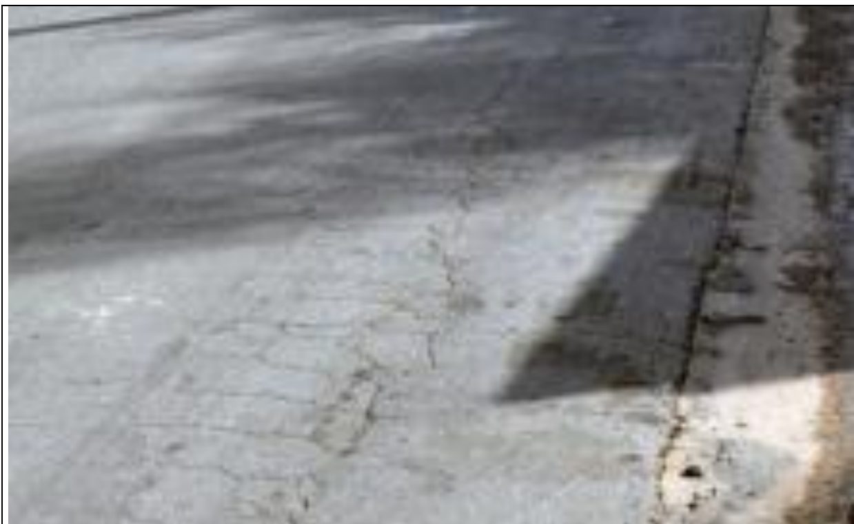
13. Lanús Pavimento agrietado.
