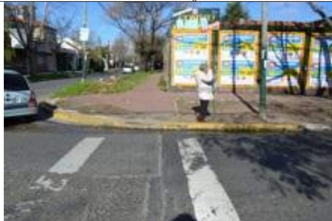
16. Lomas de Zamora Pavimento deteriorado con reparaciones.
