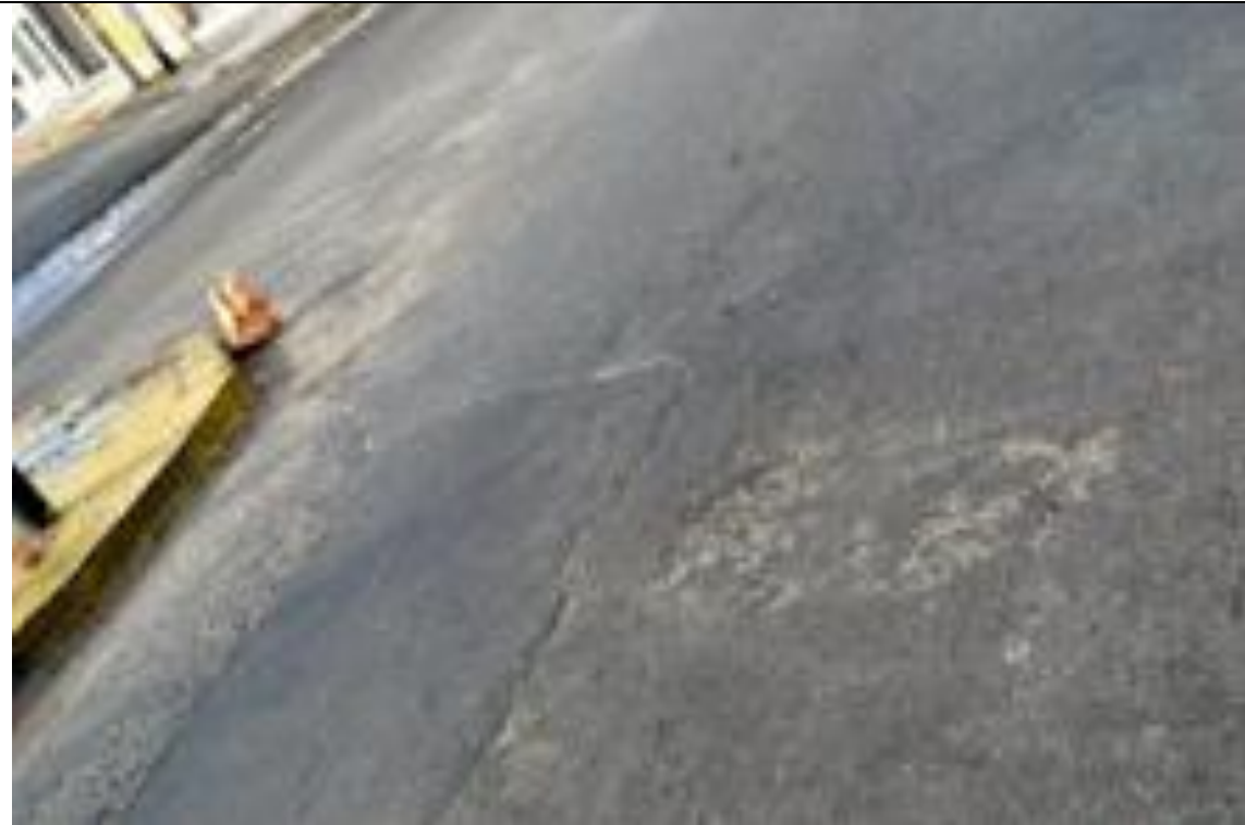
15. Lanús Pavimento agrietado.
