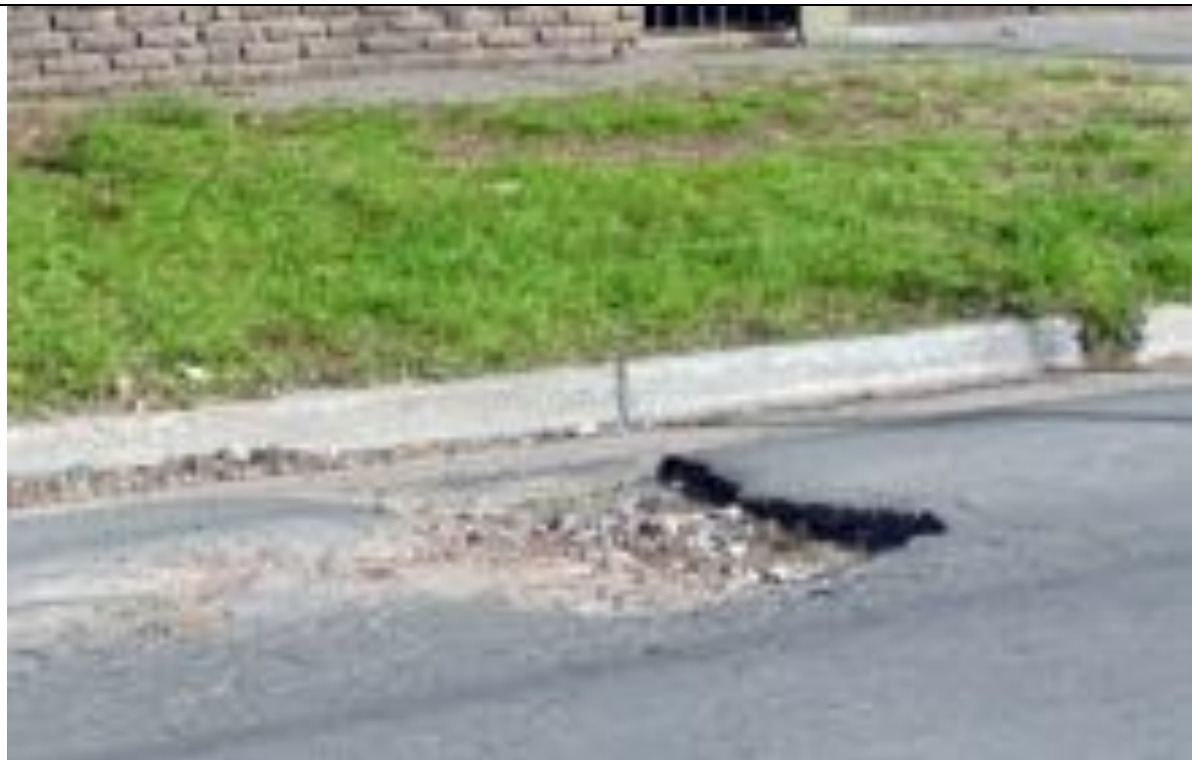
12. Lanús Pavimento deteriorado (Bache).
