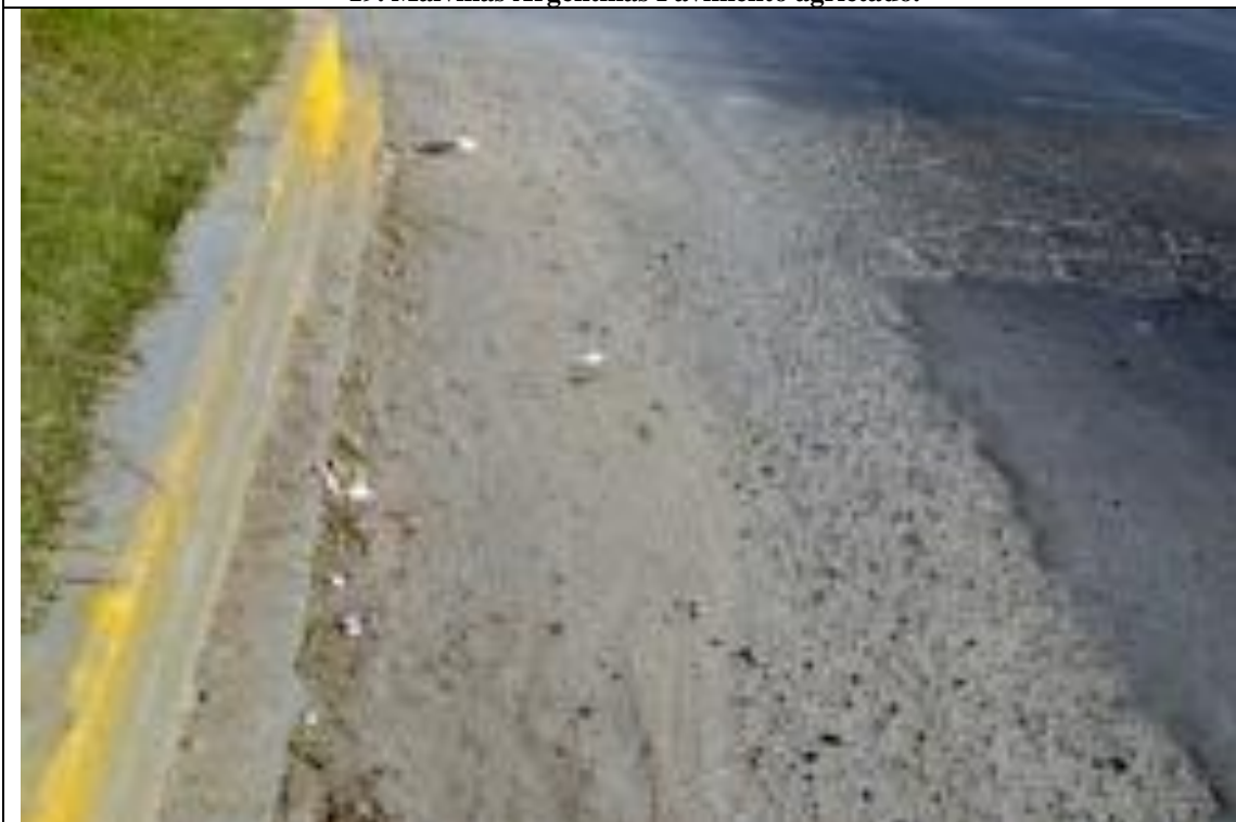
20. Tigre Pavimento agrietado.
