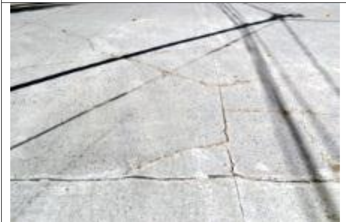
6. Ituzaingó Pavimento agrietado.
