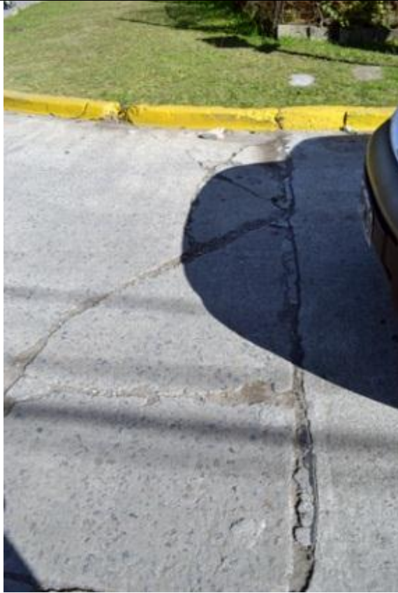
7. Ituzaingó Pavimento agrietado.
