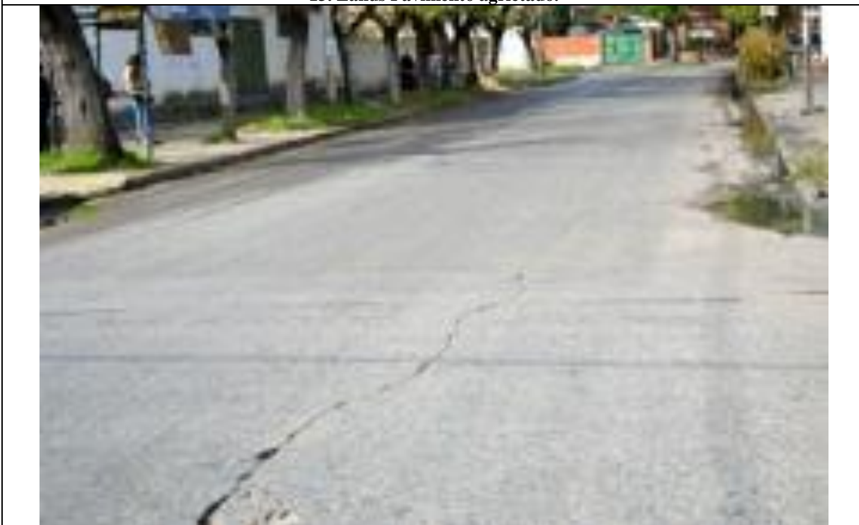
14. Lanús Pavimento agrietado.
