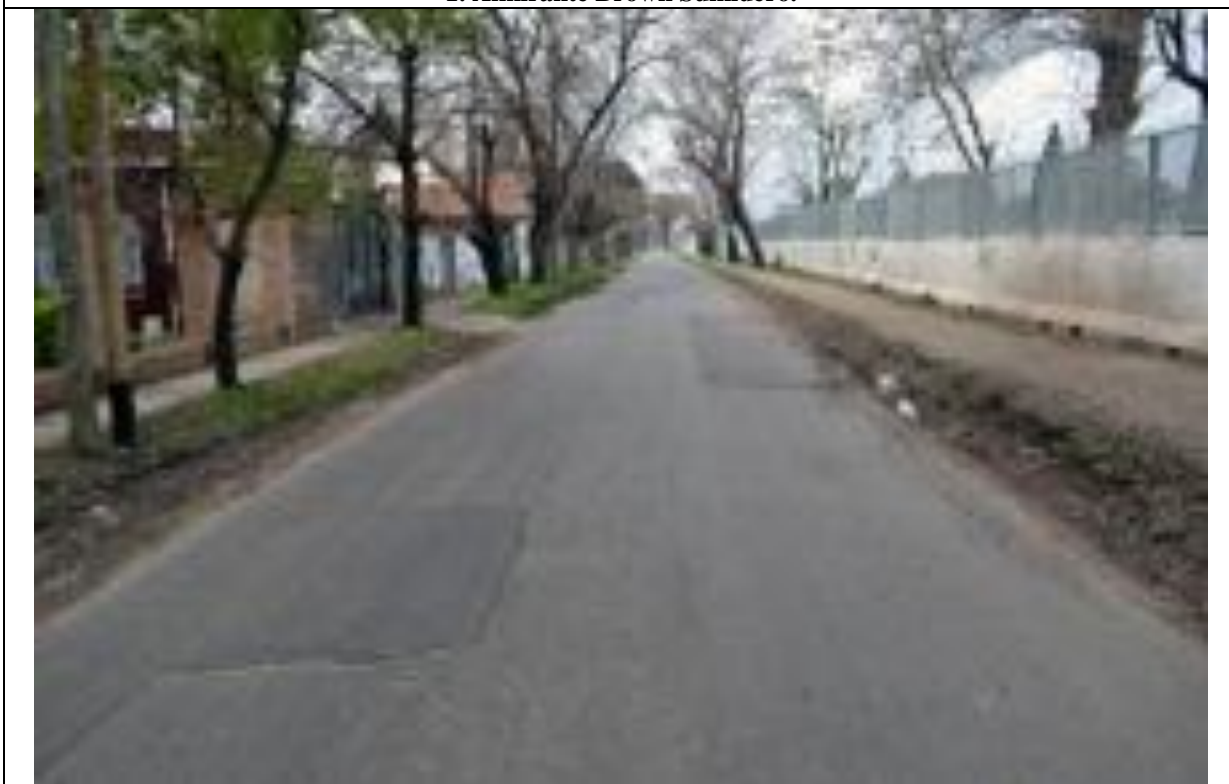
2. Almirante Brown Pavimento agrietado y con reparaciones.
