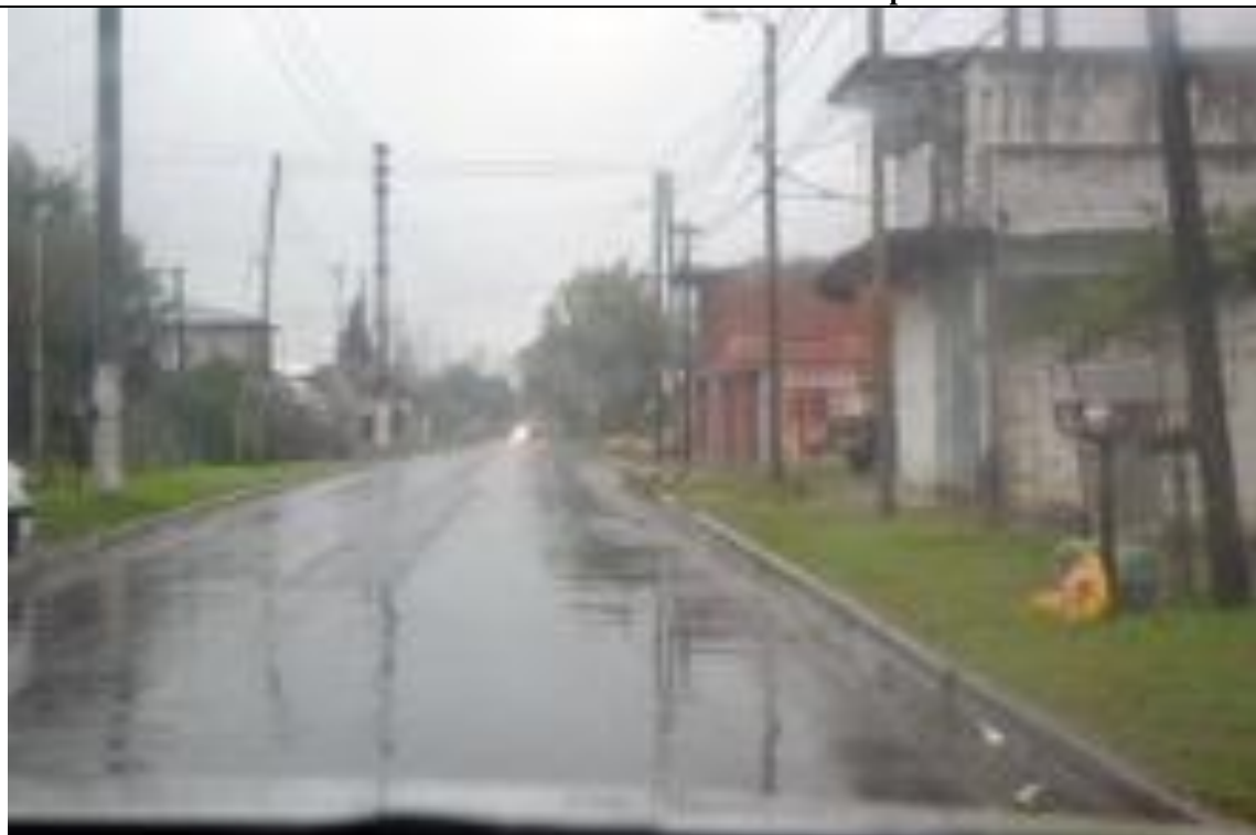
18. Malvinas Argentinas Pavimento deteriorado con reparaciones.
