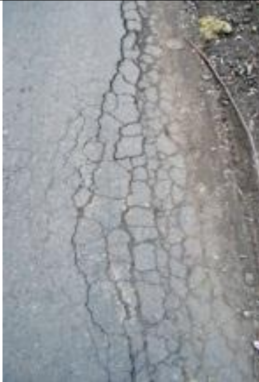
3. Almirante Brown Pavimento agrietado.
