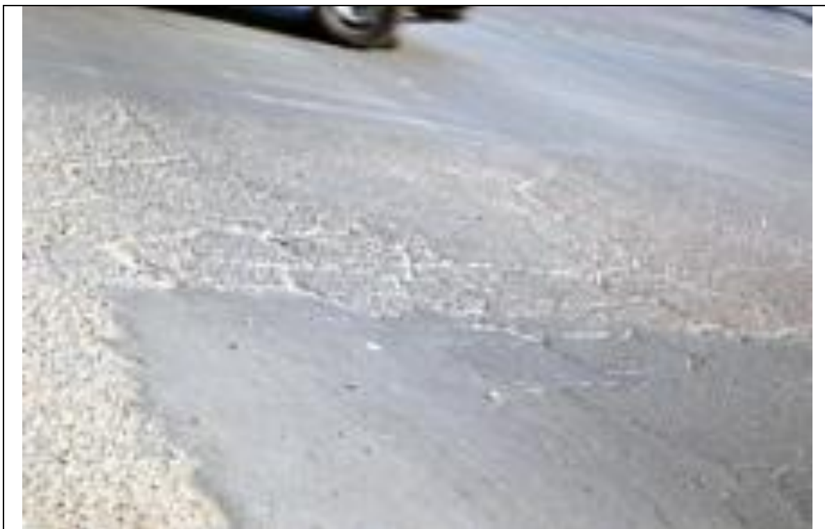
21. Tigre Pavimento agrietado.
