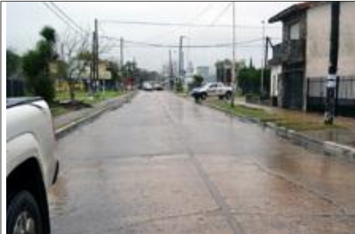
19. Malvinas Argentinas Pavimento agrietado.
