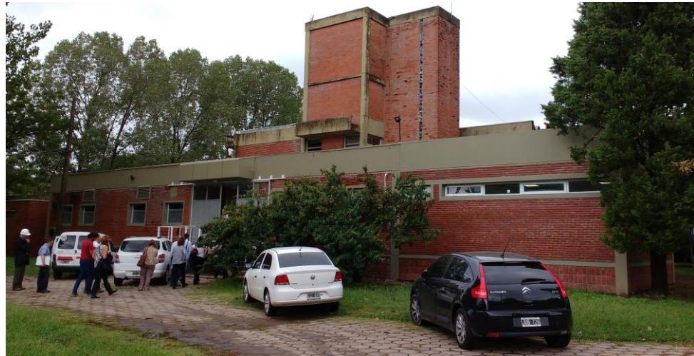
Foto 1: Frente del Instituto de Suelos donde se llevó a cabo la ampliación.
