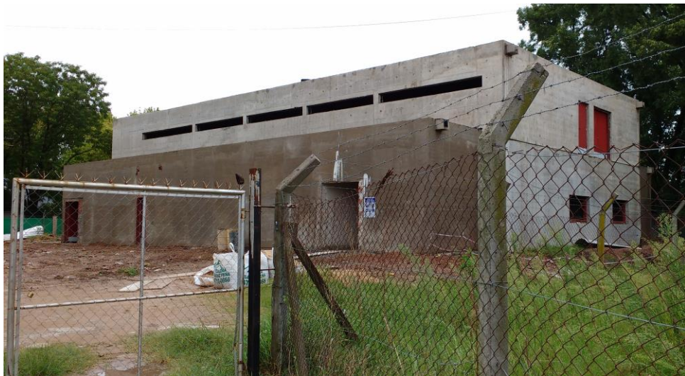
Foto 3: Obra del Bioterio con 32% de avance al momento de la visita.
