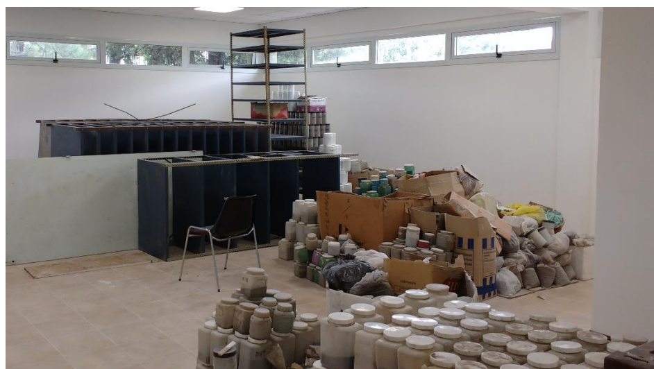
Foto 2: Obra de la sala de depósito y archivo finalizada en proceso de mudanza
