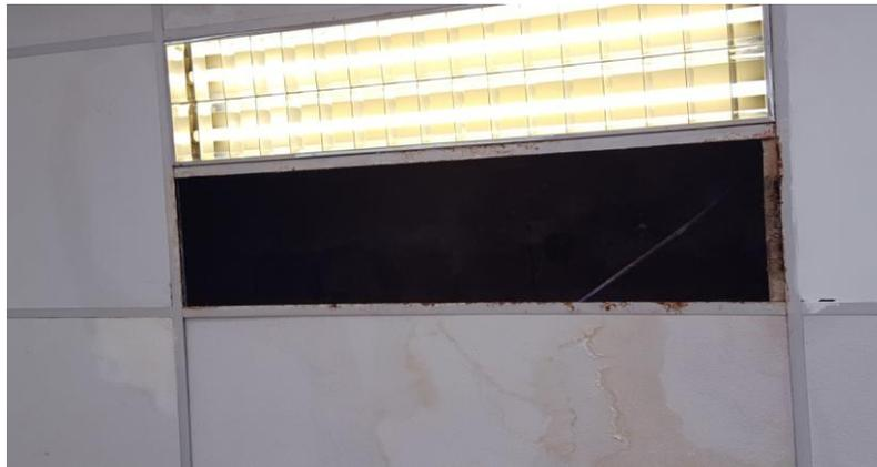
**Techo de comedor con panel roto, filtraciones y goteras**
