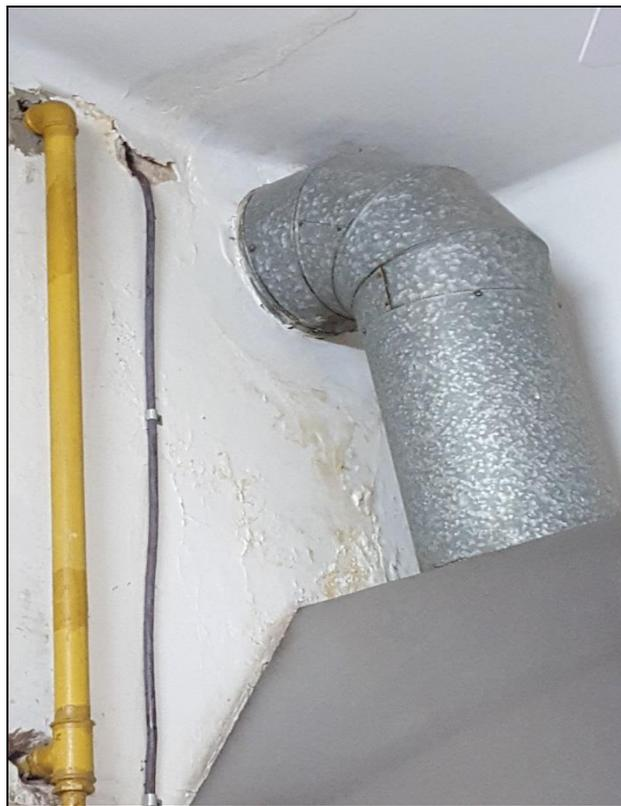
**Pared con humedad, pintura levantada y huecos sin rellenar**
