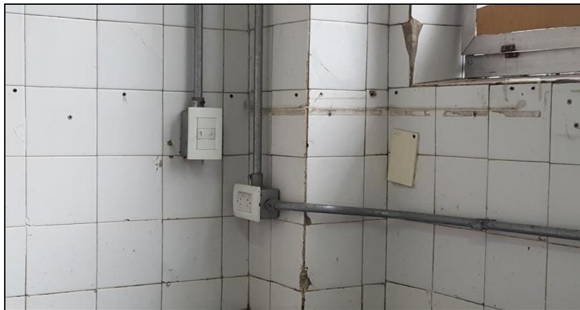
**Pared de cocina con perforaciones sin rellenar y azulejos en mal estado**
