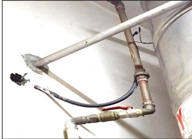
**Instalación eléctrica deficiente en depósito de víveres**
