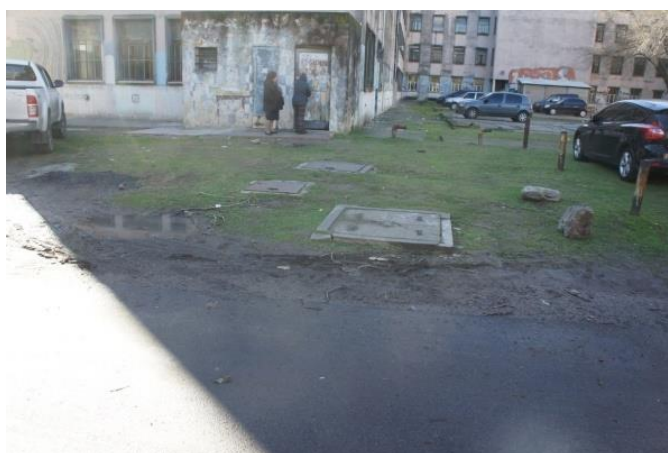
Dificultando el retiro de los residuos, por no contar con un solado adecuado.
