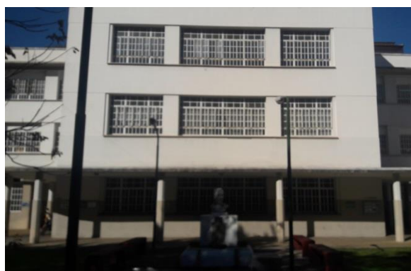
Buen estado de mantenimiento
