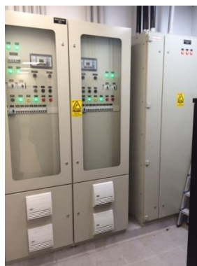
Nuevos tableros de electricidad
