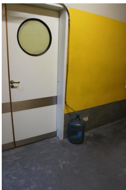
Bidón de descarga sobre el solado.
