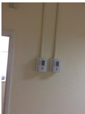
Obras en curso
