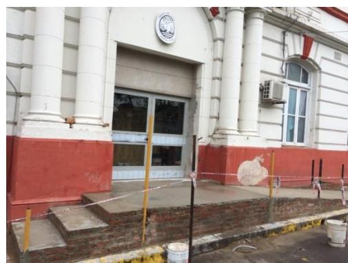
Rampa y salida de emergencia
