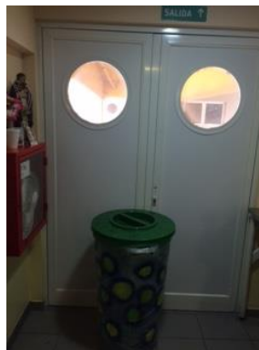
Salida de emergencia sin aislación En área estéril
