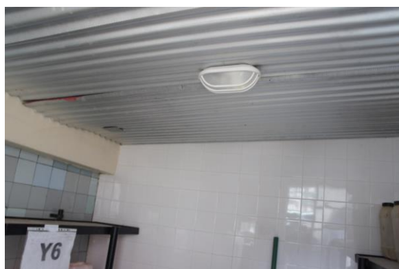
Cuenta con una cubierta metálica con pendiente, y una iluminación en buen estado.
