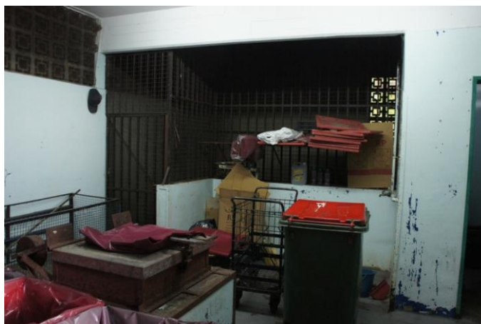
Espacio de guardado y acopio de materiales.
