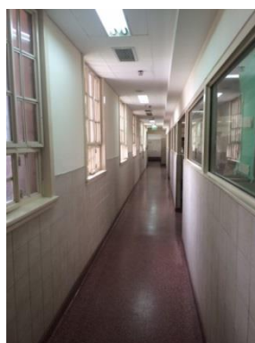
Buen estado de mantenimiento
