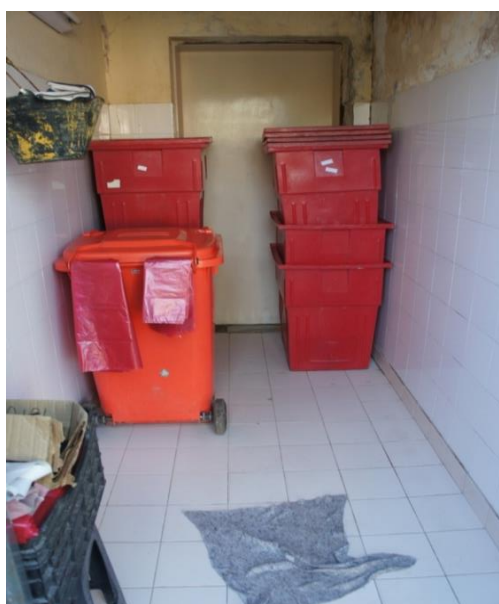
No cuenta: con pileta de piso (rejilla), ni canilla para el suministro de agua corriente para realizar el lavado de los contenedores.
