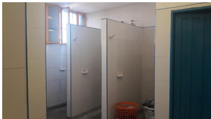
Baños en buen estado
