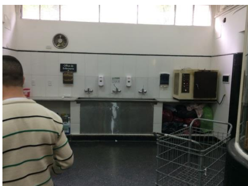
Buenas condiciones de mantenimiento y limpieza
