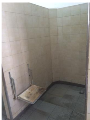
Baños en buen estado
