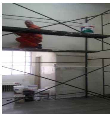
Salas en restauración
