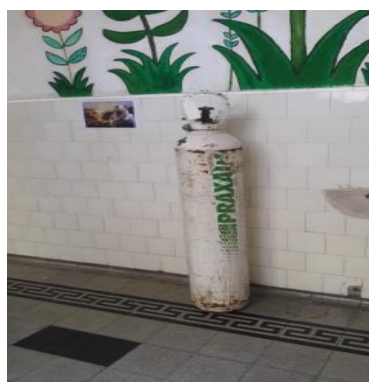
Tubos de oxígeno sin cadenas de seguridad
