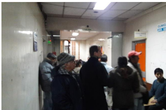
Falta de mantenimiento Cielorrasos y pintura
