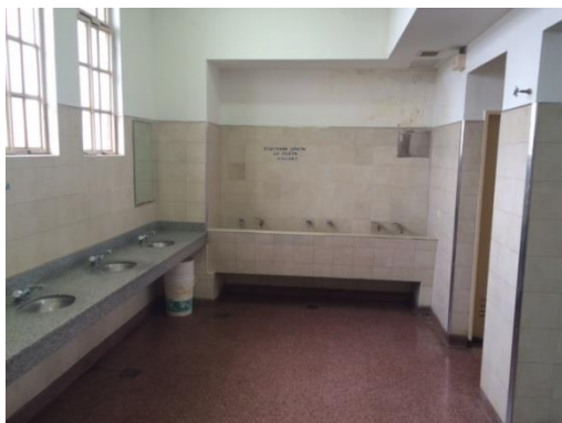
Baños en buen estado
