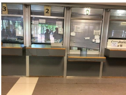
Mobiliario en regulares condiciones
