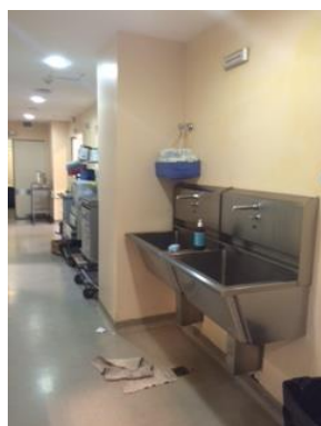
Rejilla abierta en área estéril
