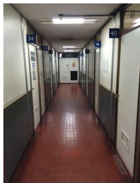
Consultorios con sistema de paneleria liviana
