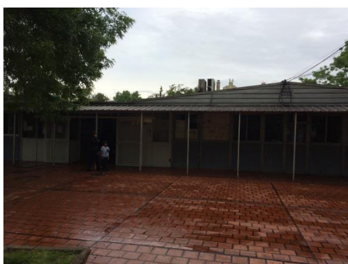
Pabellón de consultorios externos
