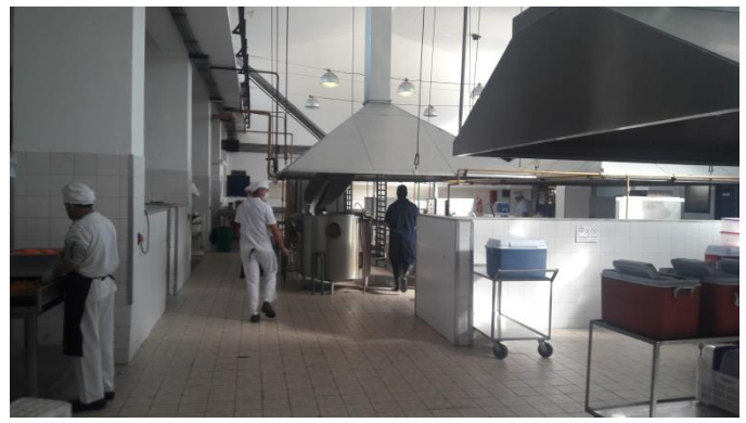
Cocina ctral en buen estado
