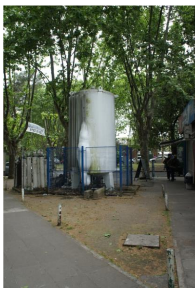
Se ubicada posterior al edificio central del Hospital, con buena accesibilidad.
