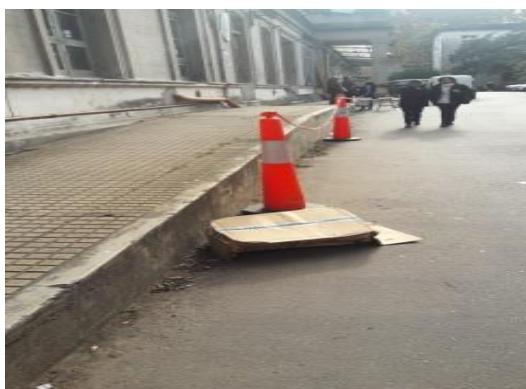
Falta de limpieza en áreas exteriores
