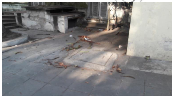
Falta de limpieza en áreas exteriores
