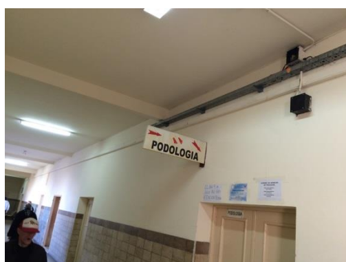
Instalacion área central
