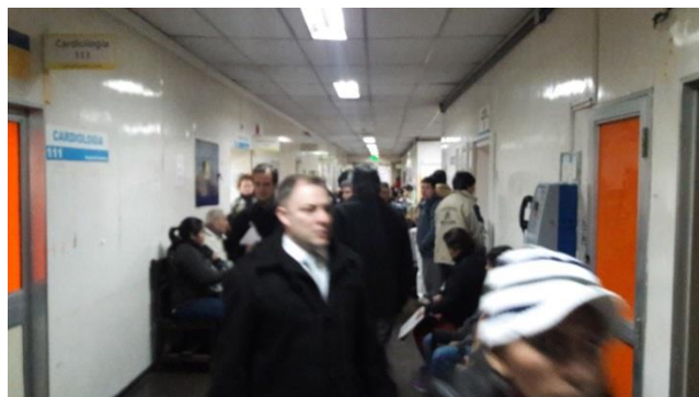
Falta de mantenimiento Cielorrasos y pintura
