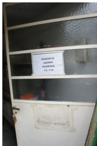
Acceso, puerta metálica con vidrio.
