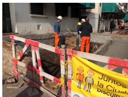
Obra en ejecución áreas exteriores
