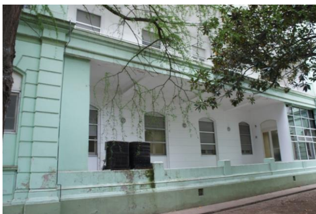
Sobre la planta baja de los pabellones del hospital se halla un pasillo semi cubierto (recova).
