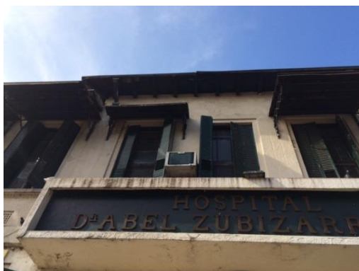
Obra en ejecución áreas exteriores
