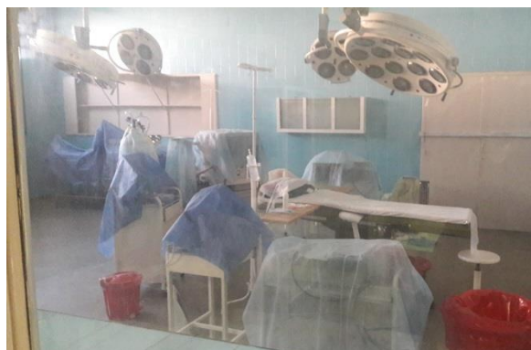
Filtración en área de cirugía
