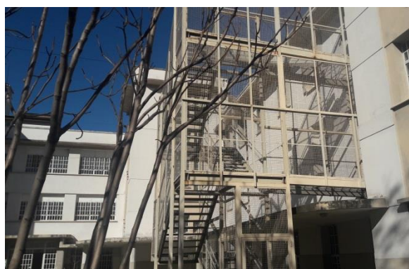
Escaleras de escape
