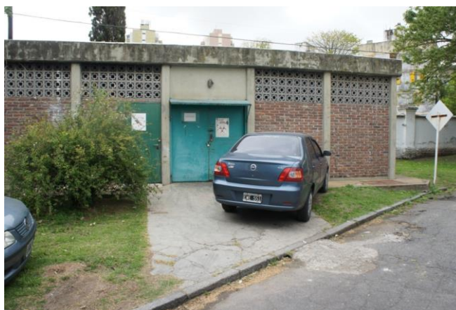
Obstrucción sobre el área de los depósitos, el personal del Hospital estaciona sus vehículos en forma incorrecta.
