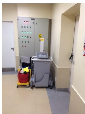
Nuevos tableros de electricidad
