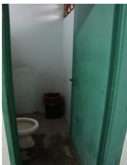
Baño, utilizado escasamente por el personal de traslado.
