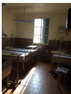
Habitaciones en buen estado
