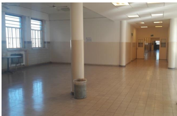
Salón de usos múltiples en buenas condiciones
