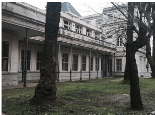
Buen estado de mantenimiento
