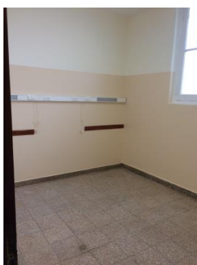
Obras en curso
