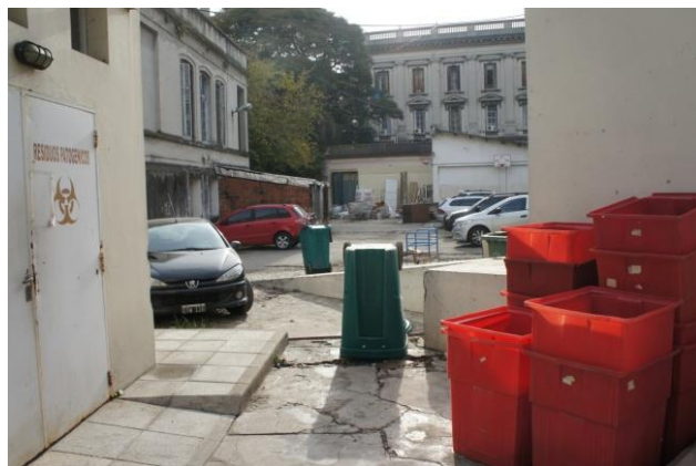
Dificultad para la maniobrabilidad del camión de retiro de los residuos (nivel vehicular).
