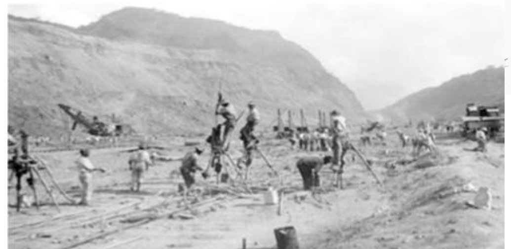
Obras do Canal do Panamá
