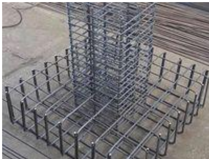
GAIOLA ESTRUTURAL DE AÇO
