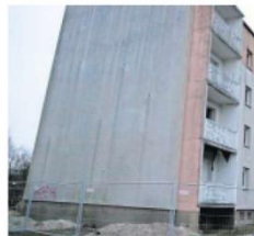
Der alte Plattenbau aus den 80er-Jahren soll er sich in einem völlig neuen Gewand
