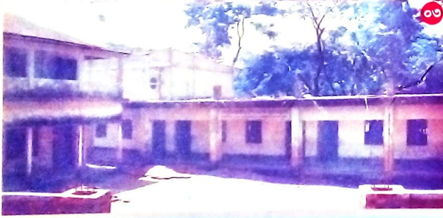
১. প্রশাসনিক ভবন ২. একাডেমিক ভবন ৩. নির্মাণাধীন একাডেমিক ভবন
