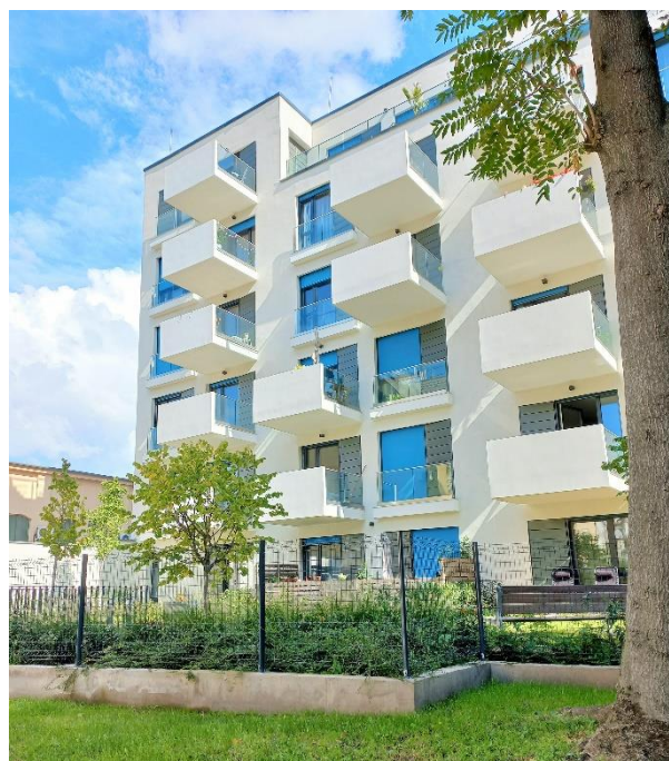
2.kép_ Forgách köz felőli homlokzat
