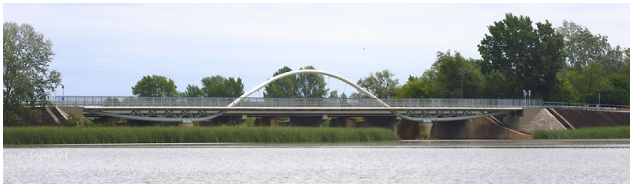
2. ábra - A hullám formavilágát folytattuk a 86 m-es Szomorka patak-híd esetében is, az ív magassága alatta marad a környező fáknak, melynek köszönhetően a látványos szerkezet belesimul a természetbe
