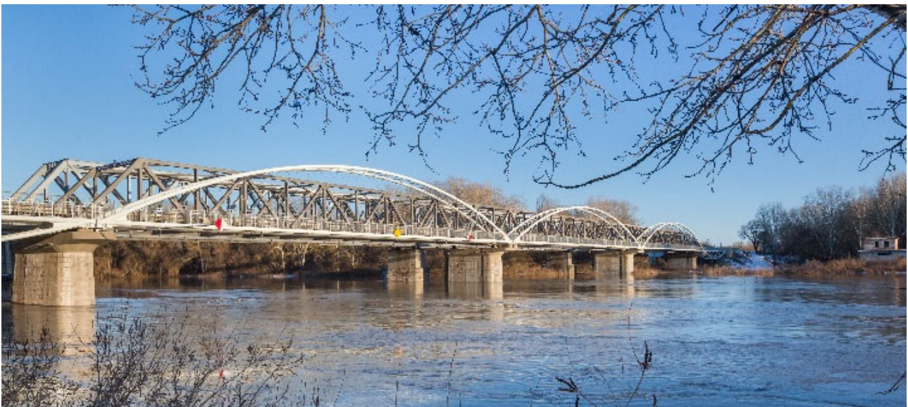
7. ábra – A kerékpáros Tisza-híd felszerkezetei
