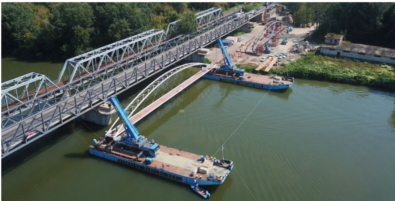
3. ábra - A Tisza-híd elemeinek beúsztatása
