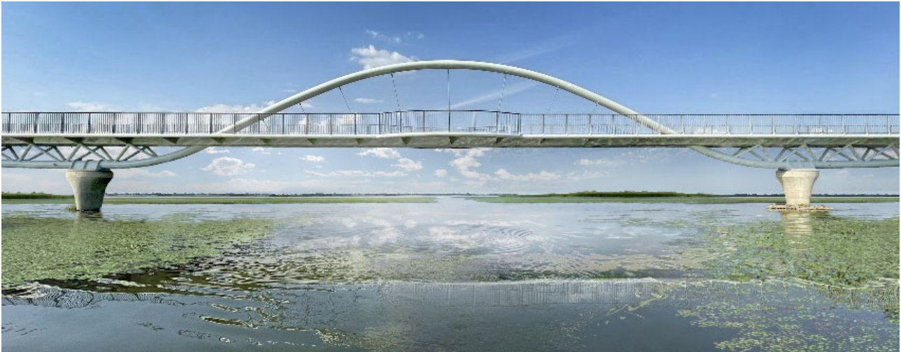
6. ábra – A Szomorka-patak hídja
