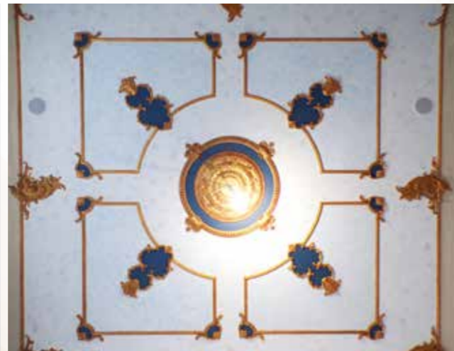
Felújítás után / After restoration
