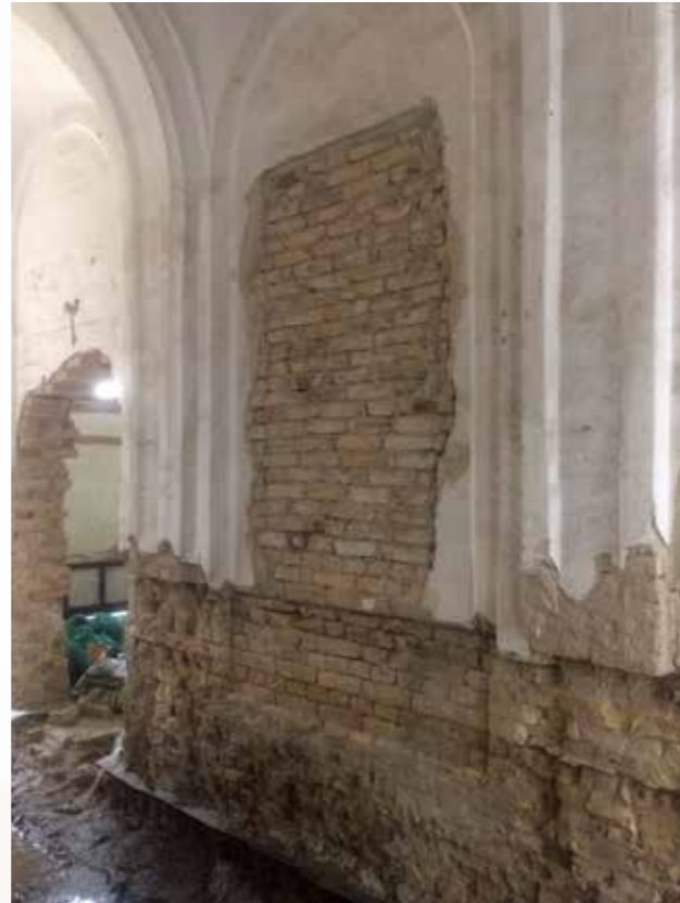
Épületdokumentációk a felújítás előtt Documentation of the building before restoration
