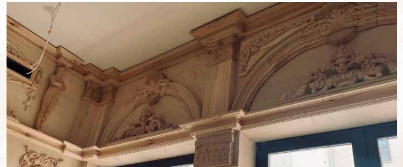
Felújítás közben / During restoration
