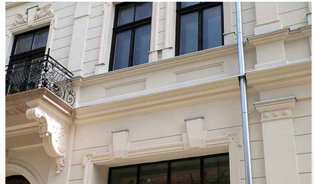
Felújítás után / After restoration
