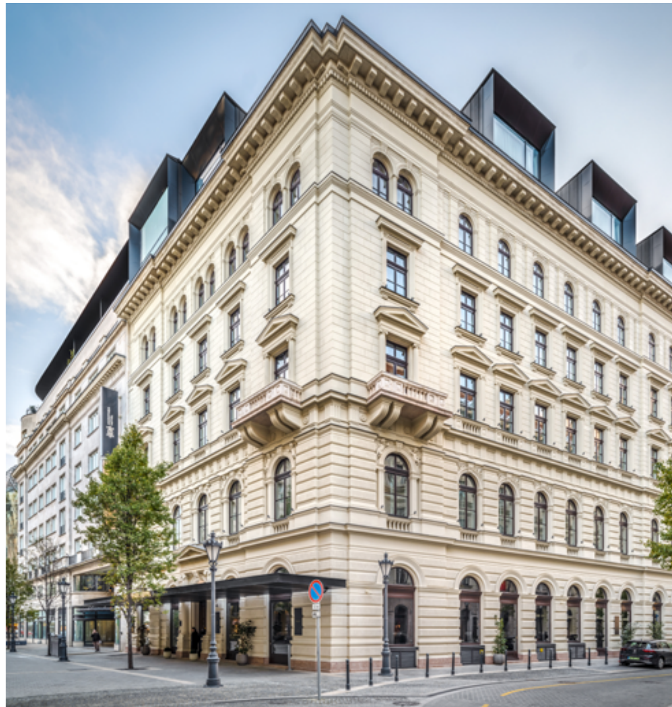
Az egykori Weber ház Dorottya és Wekerle Sándor utcai sarka. A neoreneszánsz stílusú épület a párkánymagasság feletti részén tetőtéri szállodaszobákat kapott.
