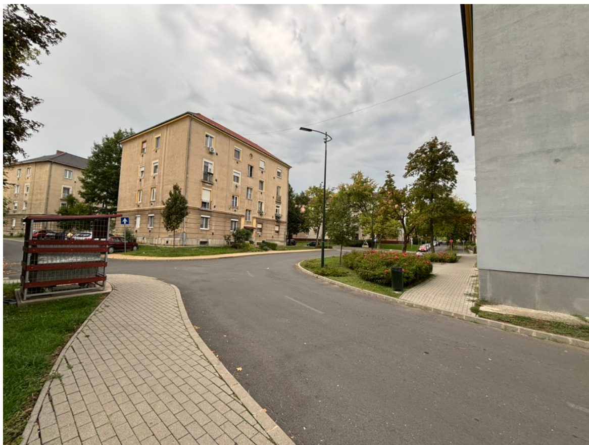
6. kép: Völgy-parki játszótér melletti út
