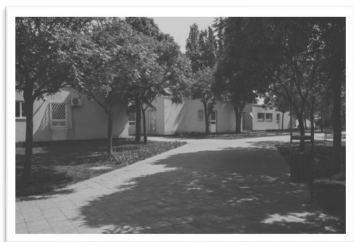
3. ábra: Az óvoda régi homlokzata
