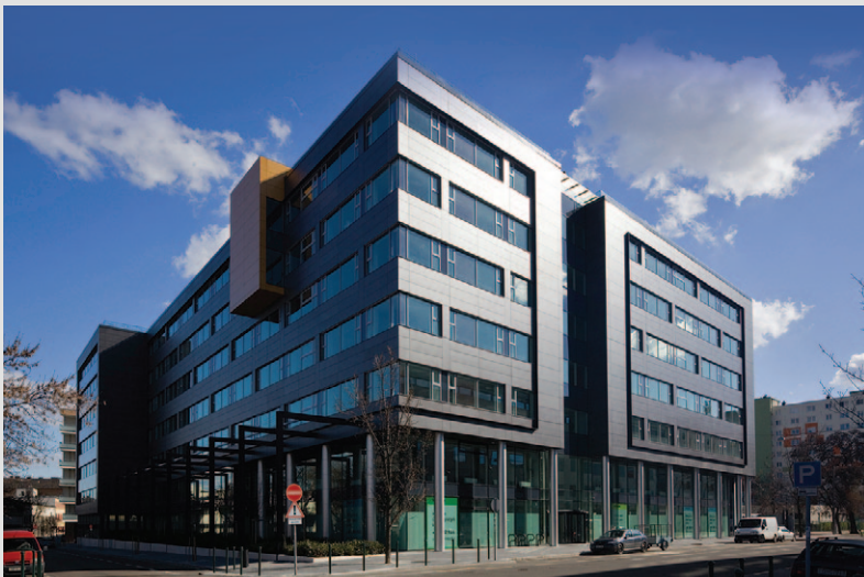
Green House Irodaház, Budapest
