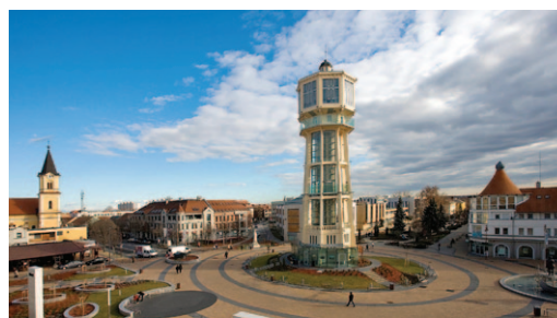
Siófok – városközpont rehabilitáció
