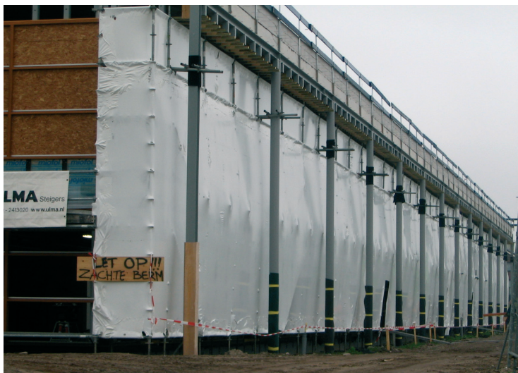
Foto: met behulp van een gespannen zeil kan een wind en regenwerende schil rond een steiger worden opgetrokken.
