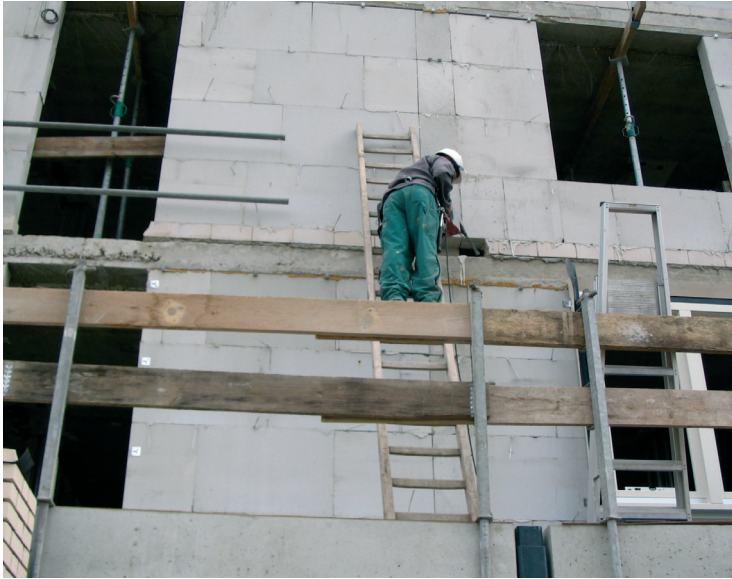
Foto: ook al is veilig leuningwerk aangebracht, daarachter moet wel veilig gewerkt worden, en dus niet boven het leuningwerk uit.
