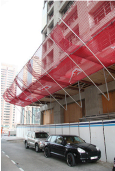
Vangschotten hout en verder uitkragend met netten
