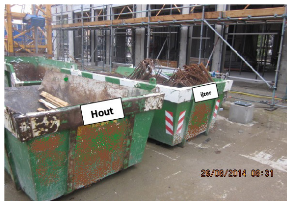
Afvalstraat realiseren op het project waar op container tekstborden worden aangebracht met afvalsoort
