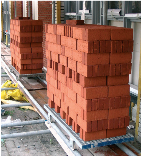
Foto: beperking van fysieke belasting door horizontaal transport van metselstenen op een railsysteem.
