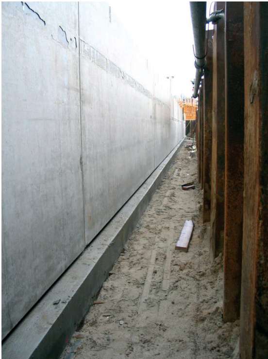
Foto: bij de inrichting van de bouwplaats moet rekening worden gehouden met het creëren van voldoende werkruimte.
