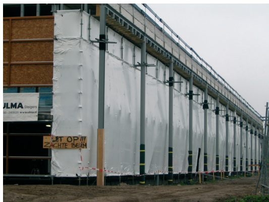
Foto: met behulp van een gespannen zeil kan een wind- en regenwerende schil rond een steiger worden opgetrokken.
