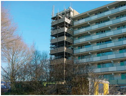
Foto: een tijdelijke doorvalbeveiliging moet dezelfde veiligheid bieden als permanent leuningwerk.
