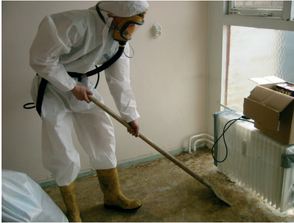
Foto: het verwijderen van asbest moet door deskundig personeel, van een gecertificeerd bedrijf, uitgevoerd worden.
