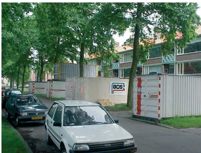
Foto: door de bouwplaats netjes en overzichtelijk te houden is de kans op ongelukken door struikelen of aanrijden geminimaliseerd.
