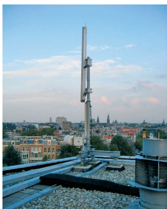
Foto: bij het werken aan een GSM-mast dient de mast tijdelijk buiten werken te worden gesteld.
