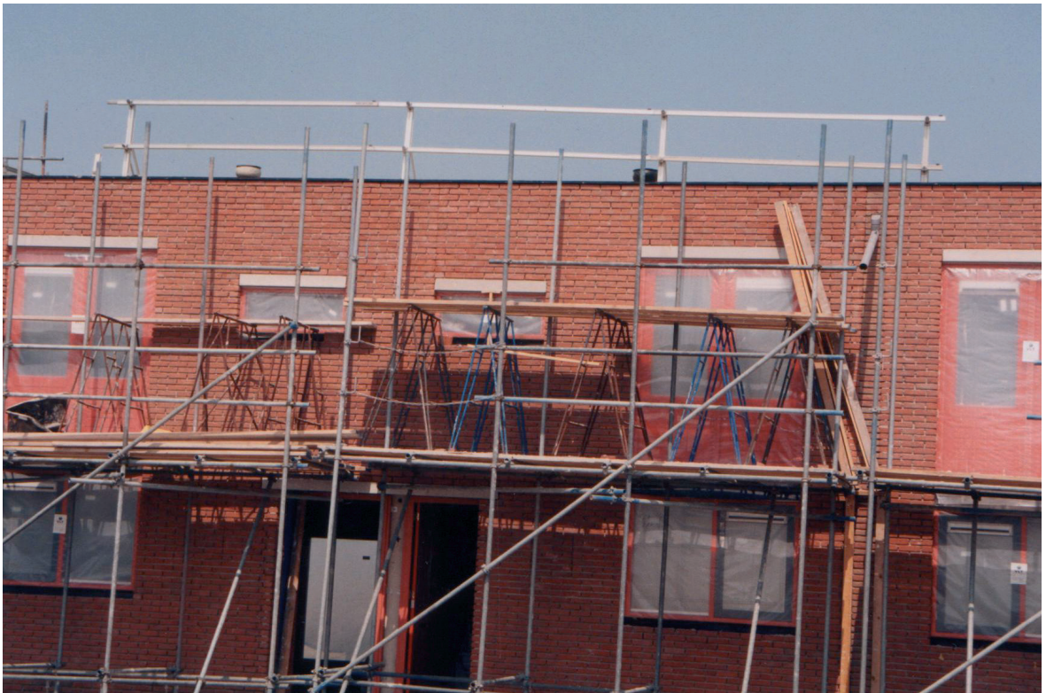
Foto: een onjuist opgebouwde steiger met onvoldoende hoog of onvolledig leuningwerk leidt tot verhoogd risico op valgevaar.
